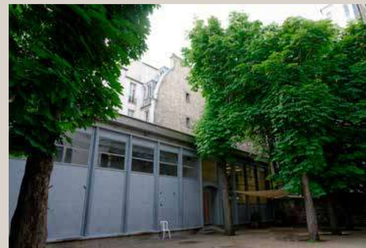
Vue actuelle du bâtiment sur cour, dont la démolition est envisagée.
