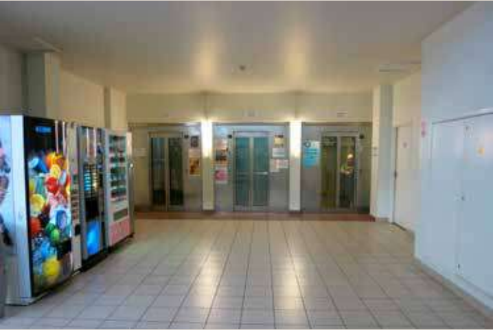
Vue actuelle de la batterie d’ascenseurs installés au début des années 2000 en façade sur la cour.
