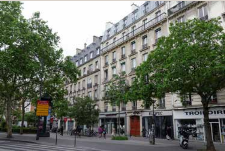
Vue actuelle de la façade sur rue.
