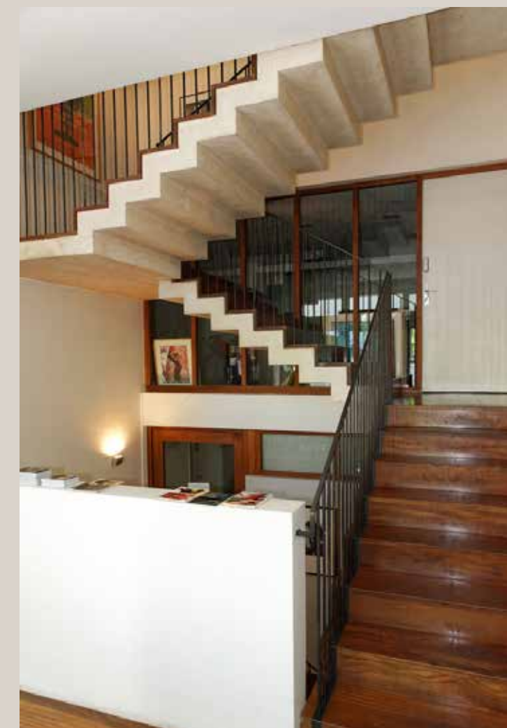
Vue actuelle de l'escalier situé dans l'axe de l'entrée.
