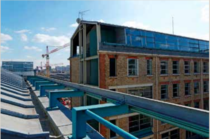
Vue de la dernière travée du bâtiment en fond de cour et du tube de la cage d'escalier qui a été créée.
