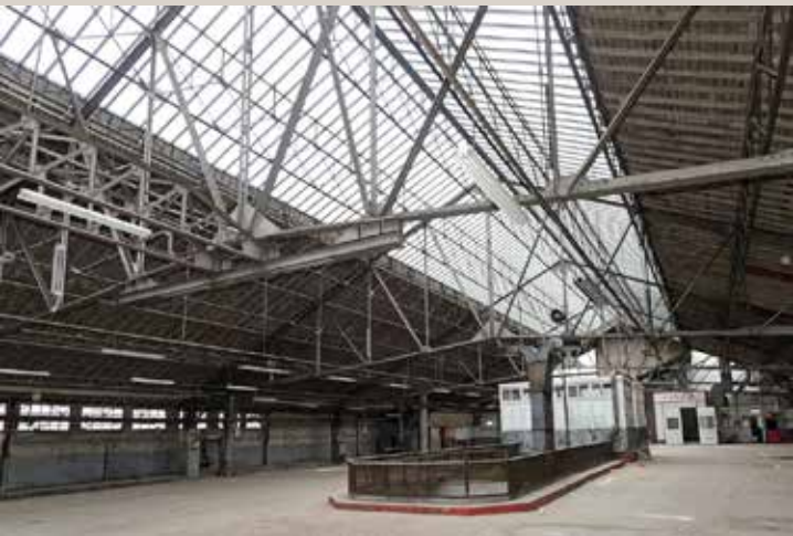
Vue actuelle du R+4 et de la toiture métallique du garage.
