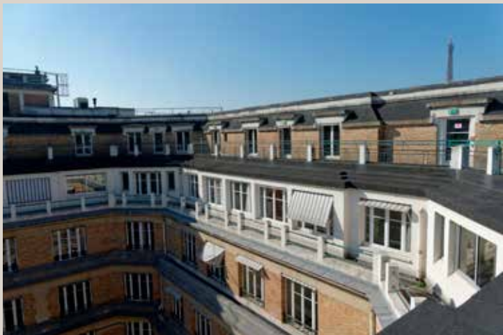
Vue actuelle du couronnement du bâtiment.
