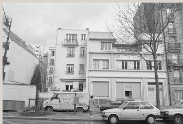
Vue de la façade sur l'avenue en 1995 (DHAAP).
