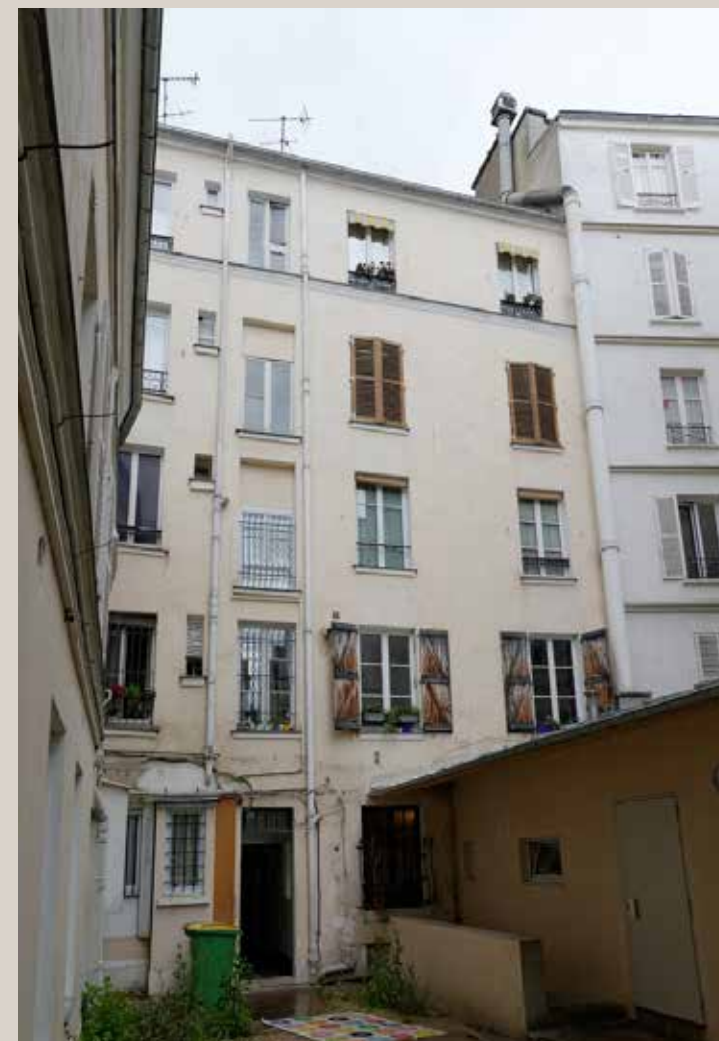
Vue actuelle du revers du bâtiment rue de Grenelle depuis la cour.
