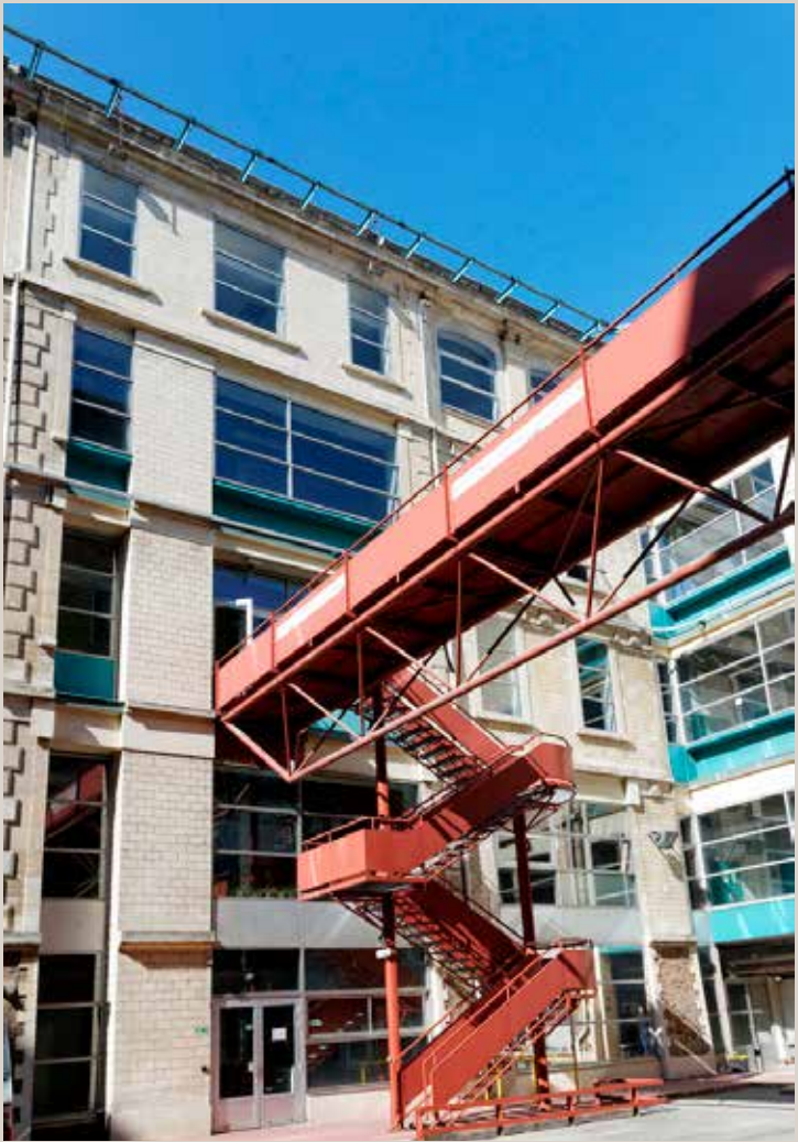
Vue des travées reconstituées sur la façade arrière du hall d'entrée et de la passerelle métallique qui réunit les deux corps de bâtiments parallèles au boulevard.
