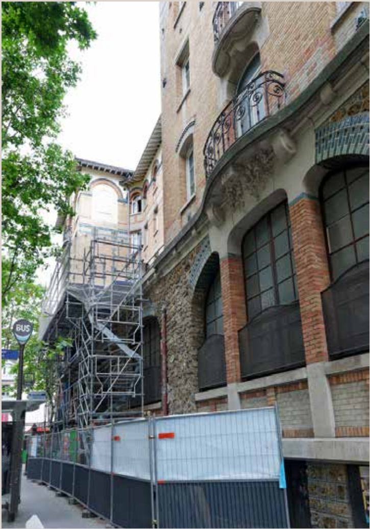
Vue actuelle de la façade sur la rue Faidherbe et des travaux d’aménagement de la crèche au R+1.
