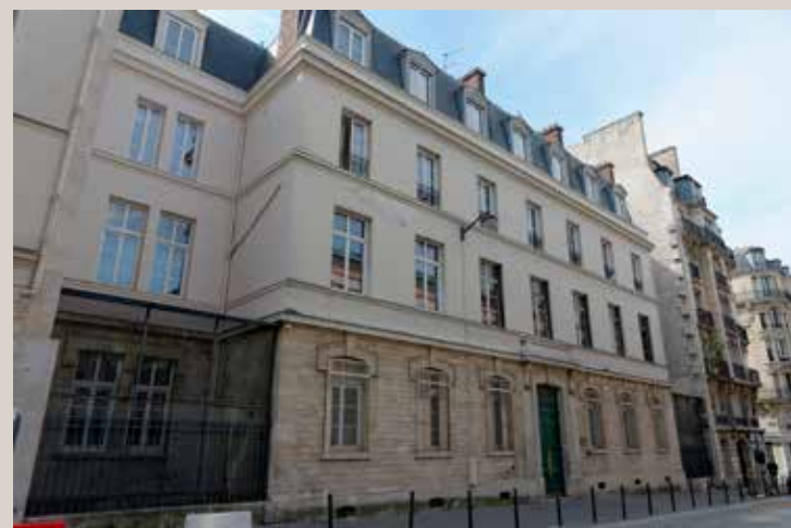
Vue actuelle de la façade sur rue.
