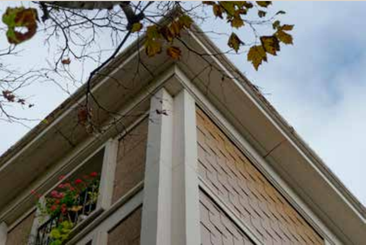
Détail d'une corniche et d'un pignon.
