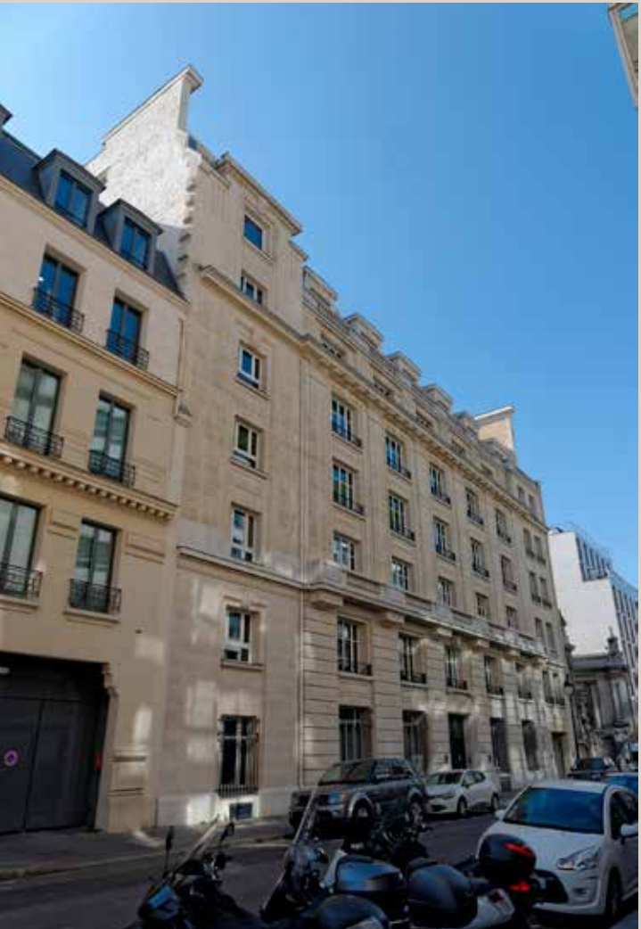
Vue actuelle de la façade sur rue.
