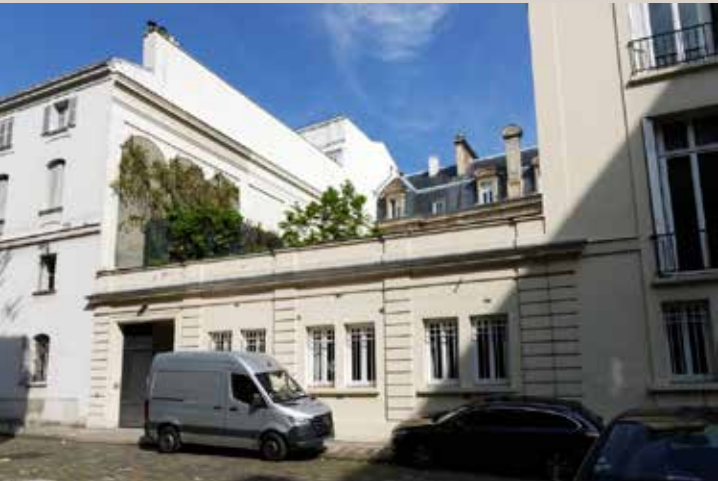
Vue actuelle de l’aile basse depuis le passage à l’arrière de l’hôtel particulier.
