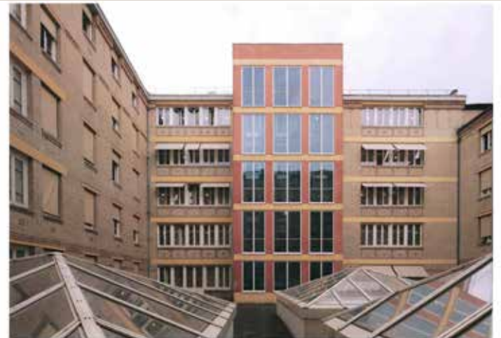
Vue actuelle de la façade sur la cour est (© Sébastien Duron architecte).
