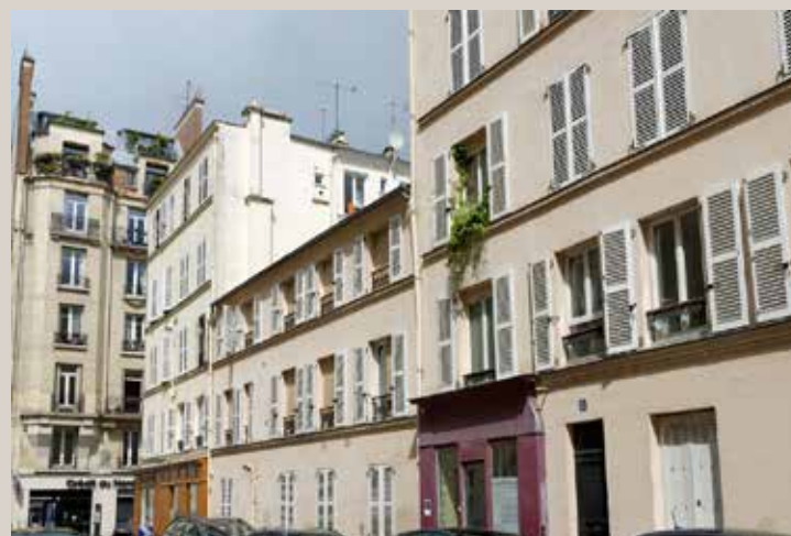
Vue actuelle du bâtiment depuis la rue Duvivier.
