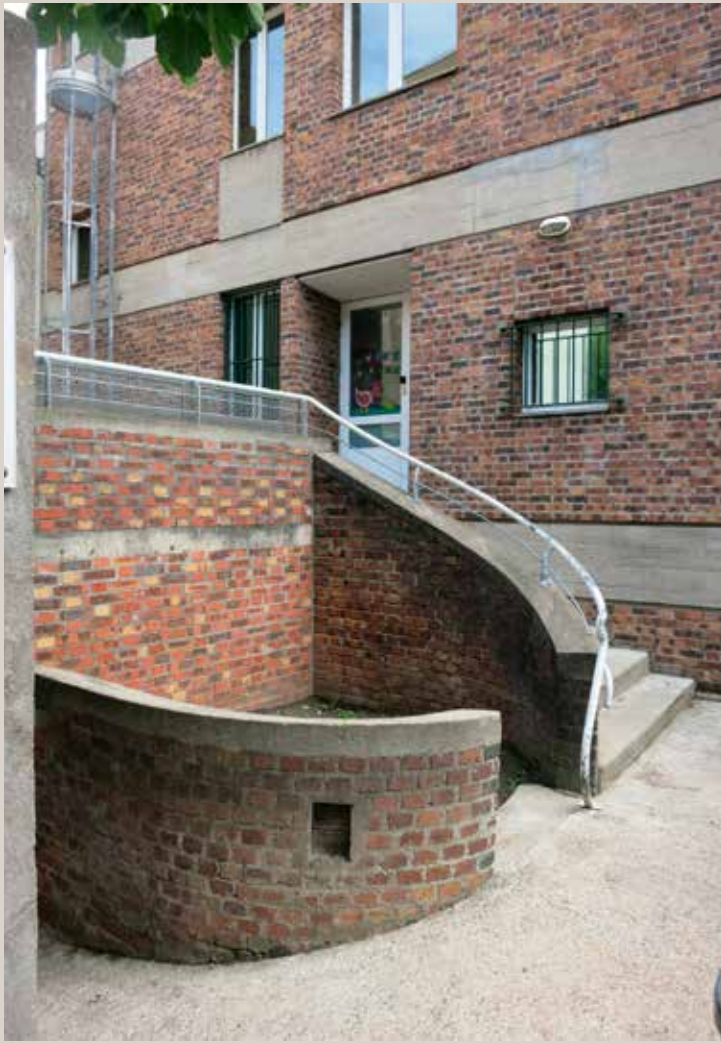
Ci-dessus et ci-contre : vue actuelle de l'accès, côté rue du Moulin-des-Prés.
