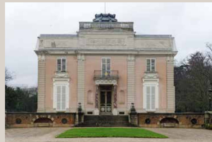
Vue actuelle de la façade du château donnant sur la cour d'honneur. Les parties hautes sont entourées d'un filet de protection.
