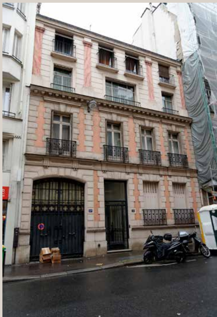
Vue actuelle de la façade sur rue.
