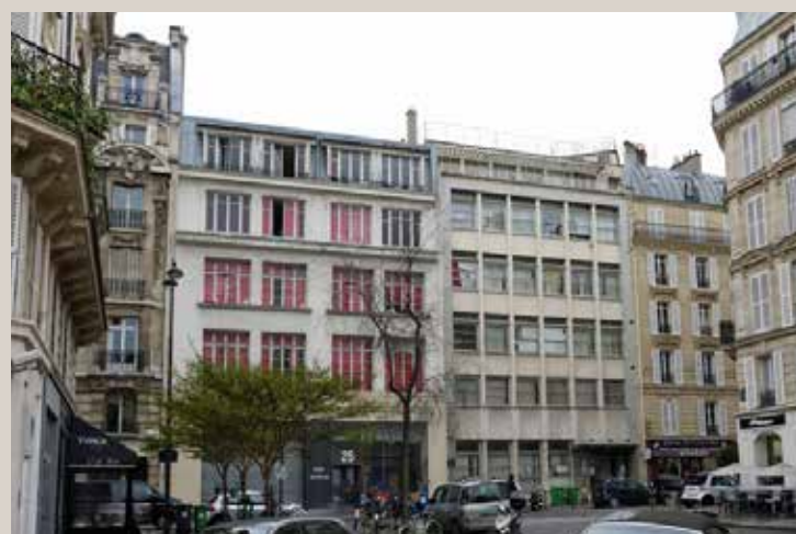
Vue actuelle des façades des n° 25 et 27 sur la rue de Constantinople.
