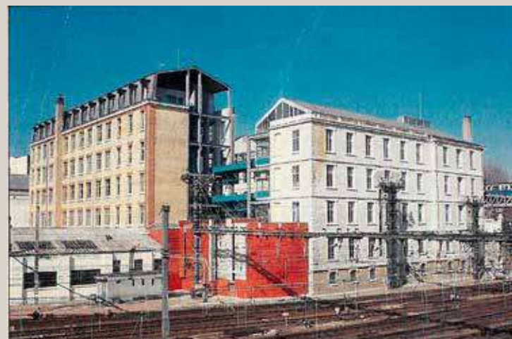
Vue en 1987 depuis l'Avenue de France et illustrant l'article élogieux paru dans Le Moniteur (© Tous droits réservés).
