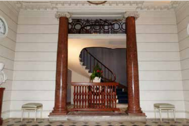
Vue de l'escalier central du pavillon.
