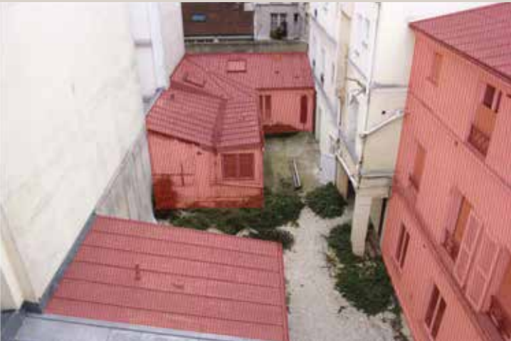
Vue actuelle de la cour, présentant les bâtiments dont la démolition est envisagée (© Hardel/Le Bihan).
