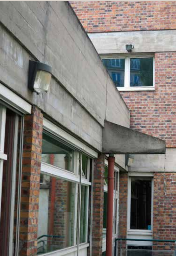
Vue de l'aile des « grands » depuis la cour. Un soin particulier a été apporté à la mise en oeuvre.
