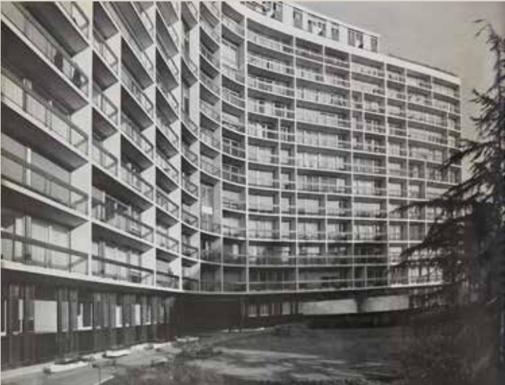
Vue de la façade (publiée dans Techniques & Architecture , n° 6, janvier 1968 / photo Henrot).
