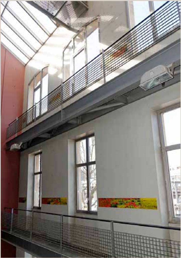
Vue du hall d'entrée, des coursives et des mezzanines qui découpent l'espace ainsi que de la verrière zénithale qui ouvre la toiture du bâtiment aligné sur le boulevard.
