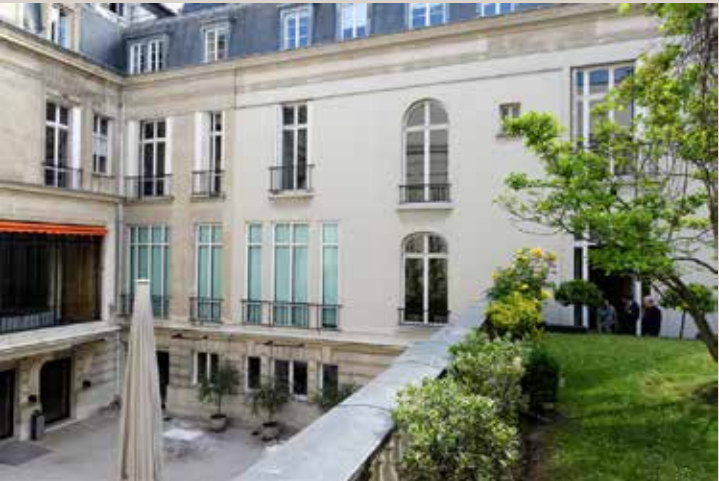
Vue actuelle de l’aile est depuis la terrasse du bâtiment en fond de cour.
