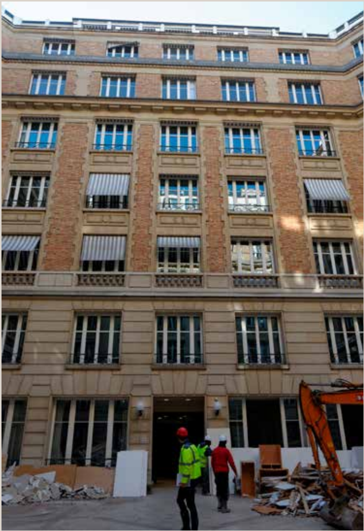
Vue actuelle de l’une des façades sur cour.
