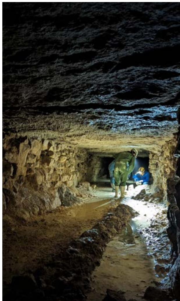
Visite d'inspection à Châtillon
