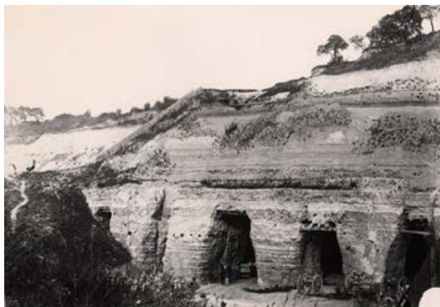
Entrées en caveau d'une carrière de gypse
