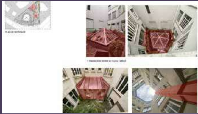
Démolitions dans les cours, 2022 (© Archibuilt).
