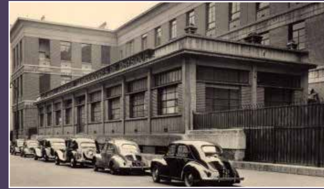
Vue des bâtiments achevés, depuis la rue Lhomond, s.d. (Site du département de physique de l'ENS).
