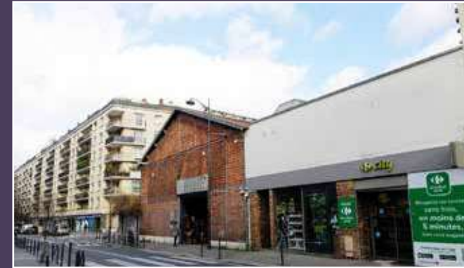
Vue de la halle implantée le long de la rue Vergniaud.
