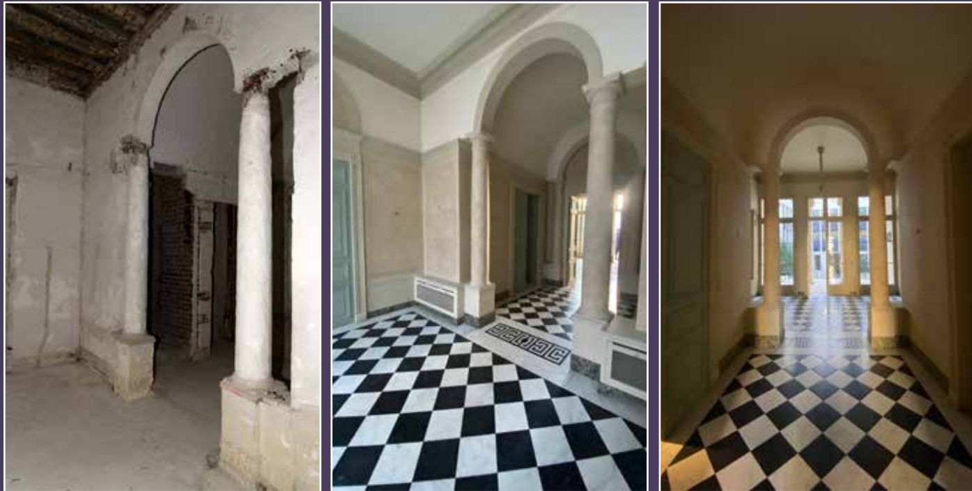
À gauche : vue actuelle de la serlienne vers l'antichambre, après le curage ; au centre : même vue avant le curage ; à droite : vue vers l'entrée du dispositif de la serlienne avant le curage.
