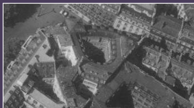
Vue des toitures complétée sur l'extension et disparition du lanternon, 1958 (© IGN-Géoportail).
