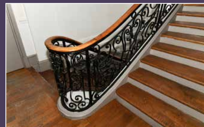
Vue actuelle de l'escalier reliant le R+1 aux étages supérieurs.
