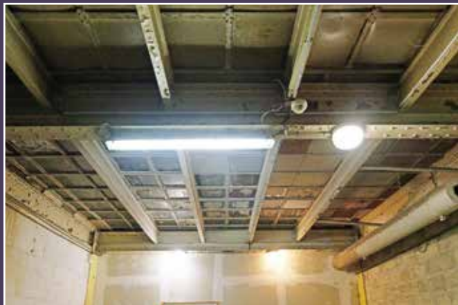
Vue du plancher de verre éclairant les espaces souterrains.
