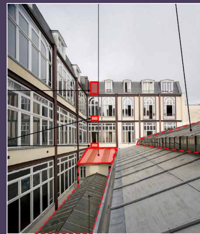
Repérage des démolitions pour mise en place de l'ascenseur, 2022 (© Atelier KAPAA).
