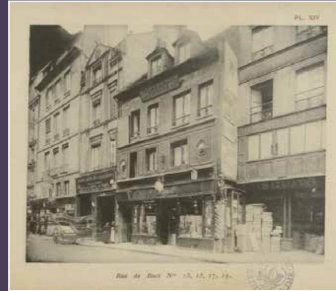
Vue de la rue de Buci, n° 13 à 17, s.d. (© BHVP).
