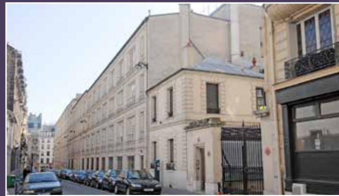
Aile C à restructurer sur la rue Pétrelle.
