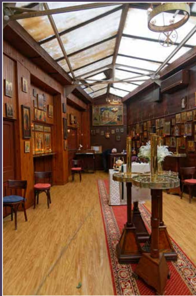
Vue de la nef de l'église avec sa charpente métallique, sa couverture en polycarbonate ondulé et les oeuvres qui l'ornent.
