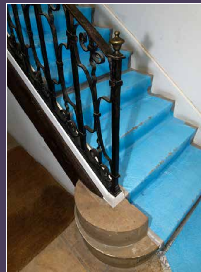
Vue actuelle de la première rampe de l'escalier du bâtiment au fond de la parcelle.
