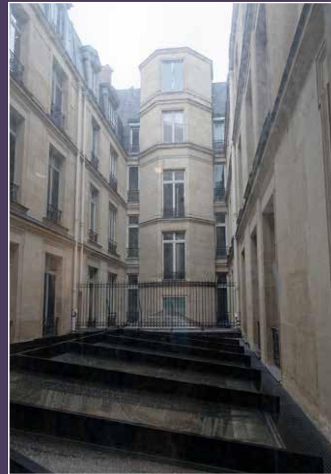
Vue actuelle de la cour A vers la cage d'escalier octogonale.
