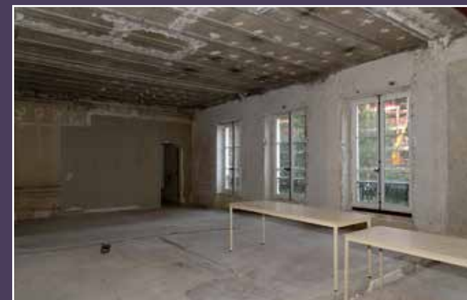
Vue actuelle du premier étage coté jardin, avec plancher en béton.
