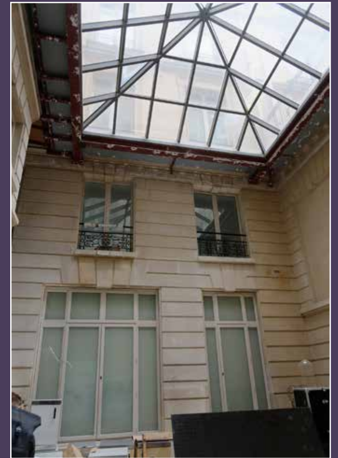
Vue actuelle du rez-de-chaussée au 14, rue Halévy, avec verrière au R+1 sur une partie de la cour A.
