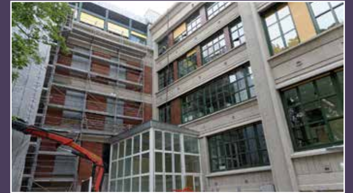
Travaux de rénovation et construction d'un sas en 2015.
