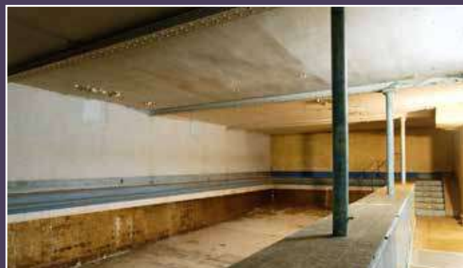
Le bassin de nage, état actuel.
