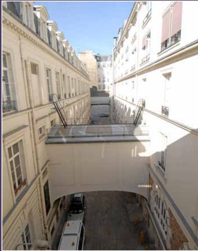
Cour, à droite revers de l'aile D Pétrelle destinée à la démolition.
