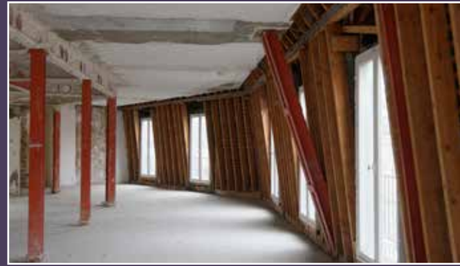
Vue actuelle du plateau à R+4 avec la structure du brisis, suite au curage.
