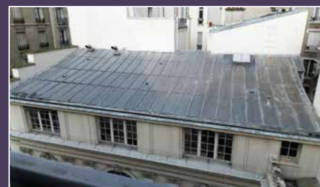
Vue actuelle de la couverture de l'atelier.
