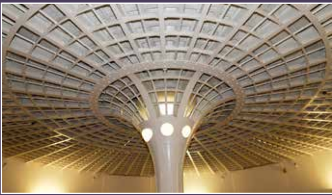
Vue de la voûte plate métallique de la salle de coffres.
