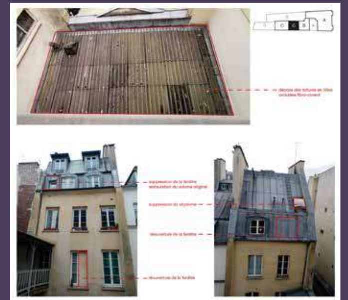
Photographies des éléments dont la démolition ou la dépose est envisagée (© Bona-Lemercier architectes).
