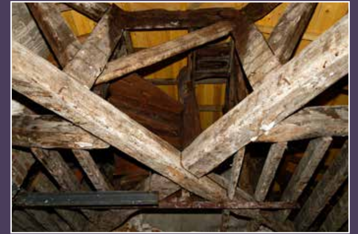
Vue actuelle de la charpente de la toiture.
