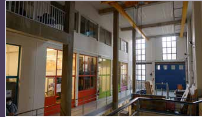
Grand hall, vue des entresolements et du quai de décharge.
