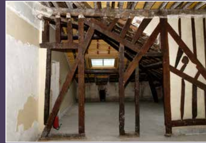
Vue actuelle de la structure en bois du dernier étage.
