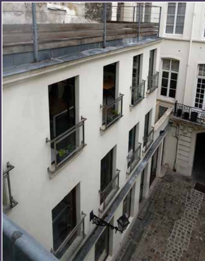
Vue actuelle de l'aile droite depuis le corps en fond de parcelle.
