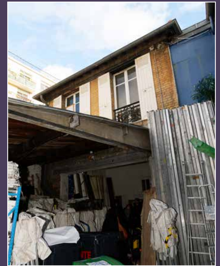
Vue du rez-de-chaussée ouvert pour lier le pavillon et la cour.
