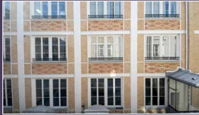
Aile C angle Pétrelle destinée à être réhabilitée.
