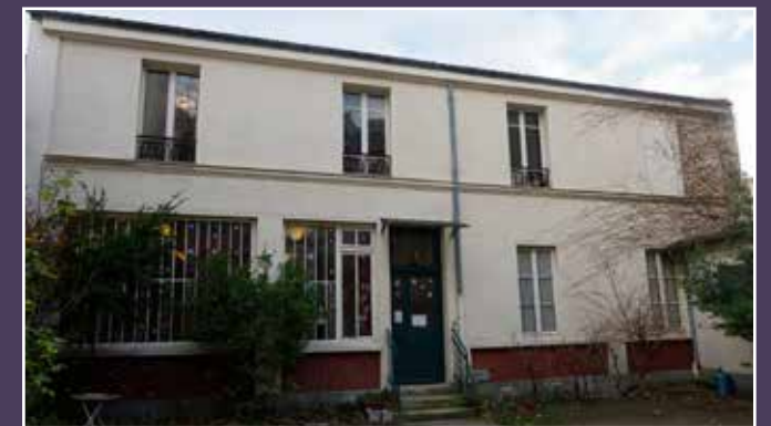
Le second corps de logis établi en coeur de parcelle.
