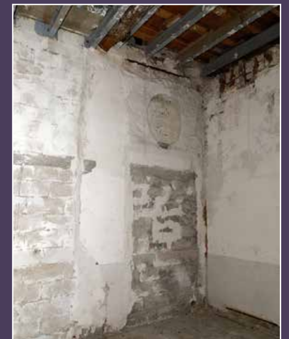
Vue de la bibliothèque, après le curage.
