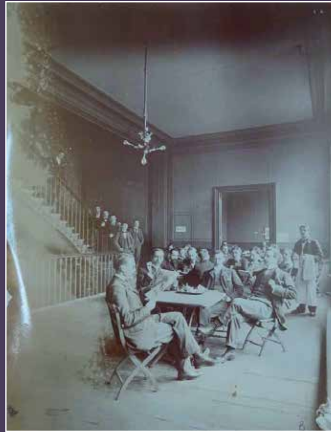
Vue du palier du premier étage en 1919 (© YMCA).
