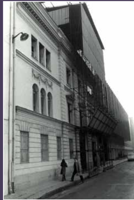
Façade de l'immeuble en R+2 au 18, rue de la Ville-l'Évêque en 1974, avec échafaudage avant sa démolition (Archives de la CVP).
