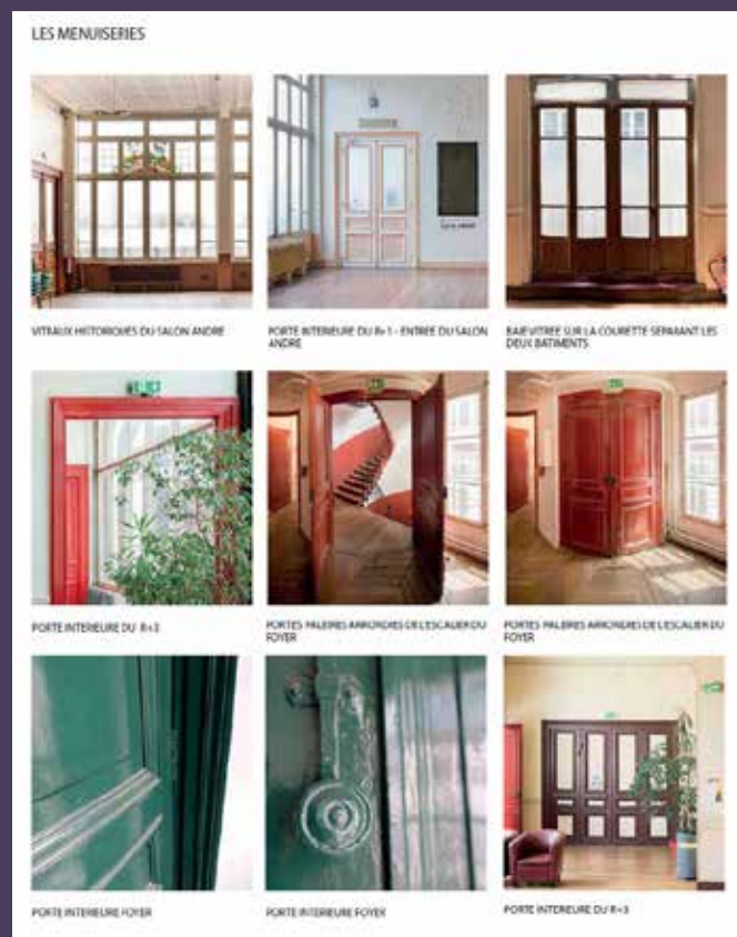
Repérage des menuiseries anciennes existantes, 2022 (© Atelier KAPAA).
