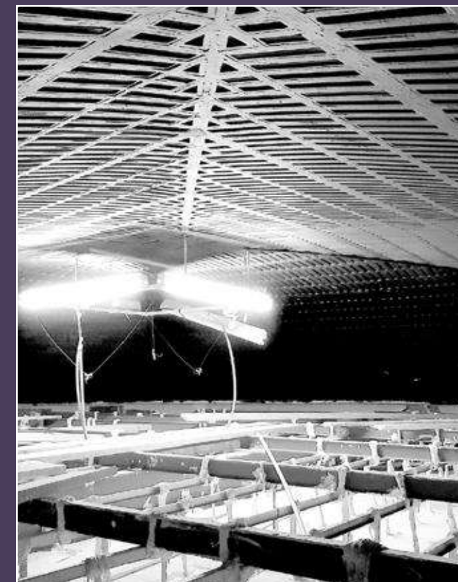
Occultation de la voûte pour réalisation d'un auditorium en 1984, Wolgensinger (© Archives de Paris).
