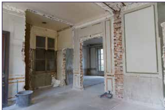
Vue du « curage » intérieur.
