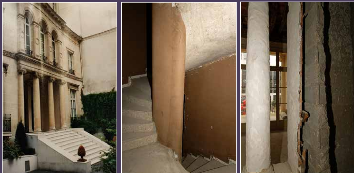
À gauche : vue de l'escalier d'accès à l'hôtel avant la modification de 1996 ; au centre : vue actuelle de l'escalier de service en béton réalisé lors de la campagne des travaux des années 1970 ; à droite : vue d'un détail d'un cloisonnement.
