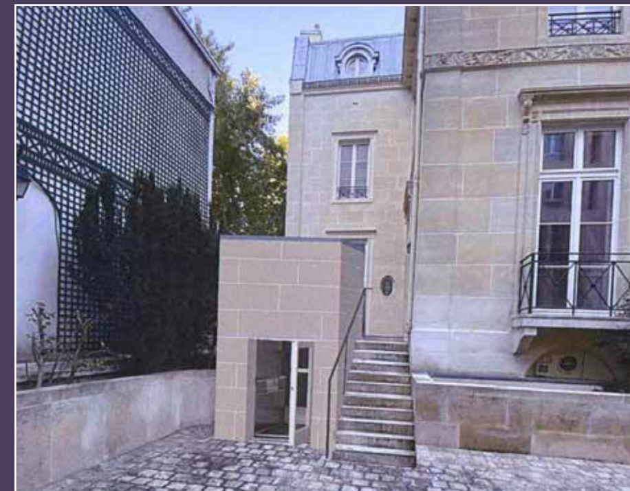
Vue d'insertion du monte-PMR à l'extérieur de l'hôtel (© Artquad Architectes).
