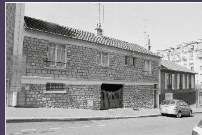
Le même bâtiment disparu et sa jonction avec le pavillon qui est l'objet du projet (Archives CVP M Paturange).
