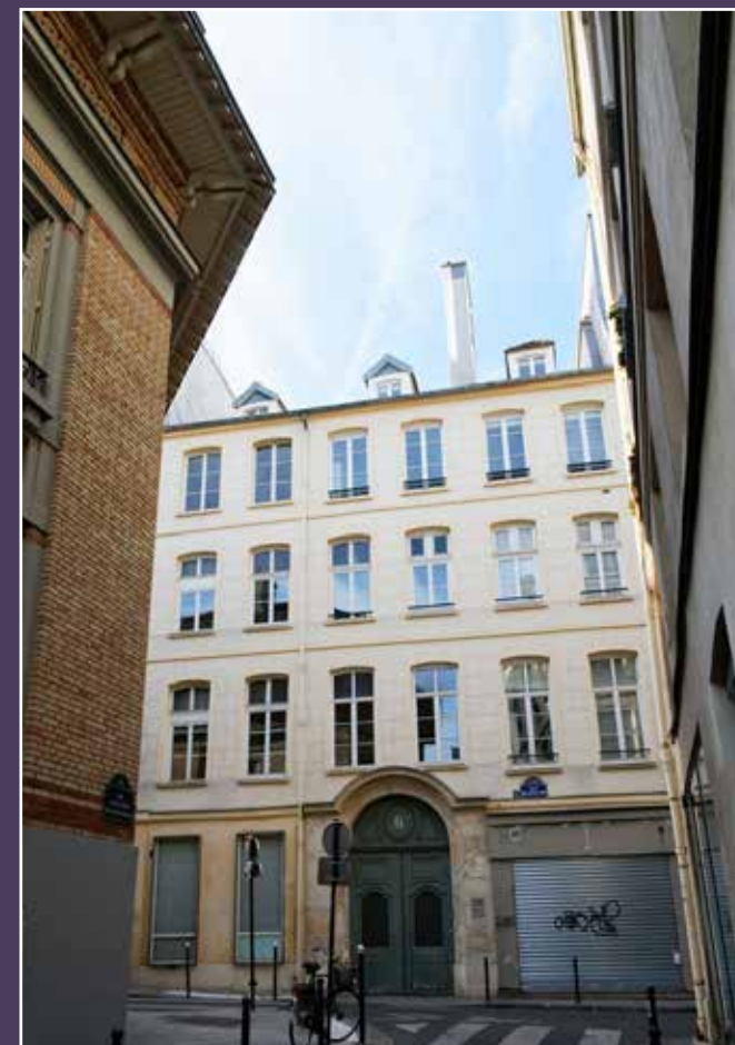
Vue actuelle de la façade rue Beauregard.
