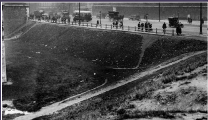
Vue de la porte de la Villetta en 1919 (Charles Lansiaux / Commission du Vieux Paris).
