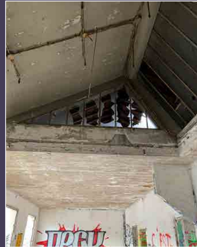
Détail des baies zénithales.
