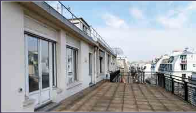
Extension de C. Le Coeur sur la terrasse.
