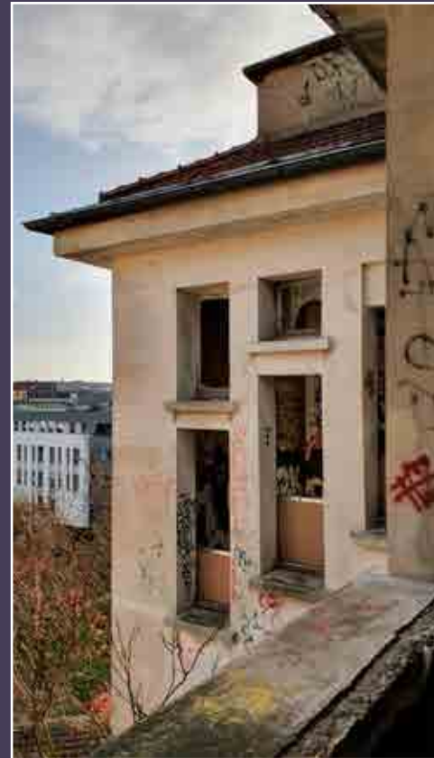
Détail des baies de la cage d'escalier au revers du bâtiment.
