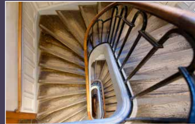
Escalier du bâtiment d'administration.
