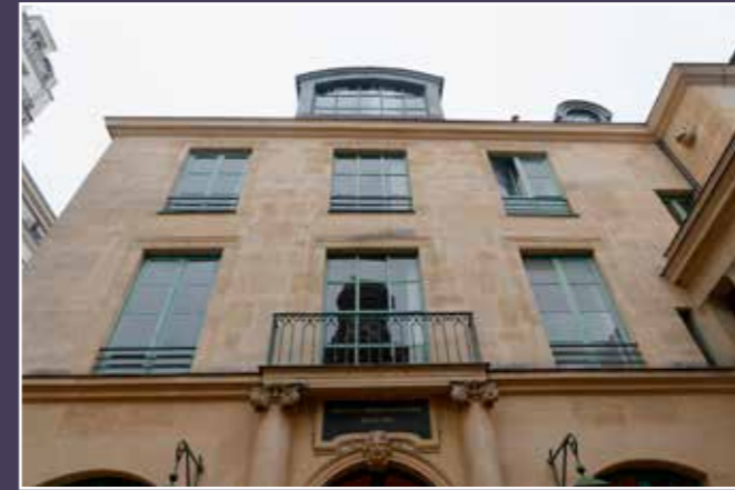
Élévation au-dessus du rez-de-chaussée du bâtiment de l'administration.
