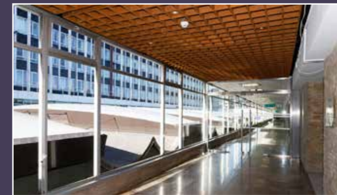
Vue d'un espace de circulation autour de la verrière de la gare.
