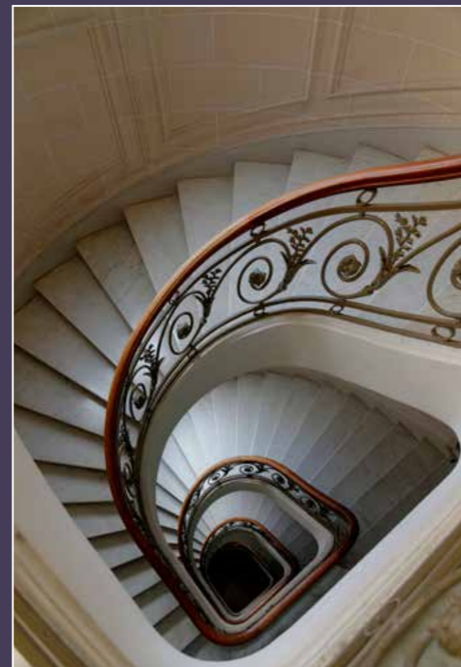
Escalier principal au 14, rue Halévy dans un reportage du DHAAP de 2018.
