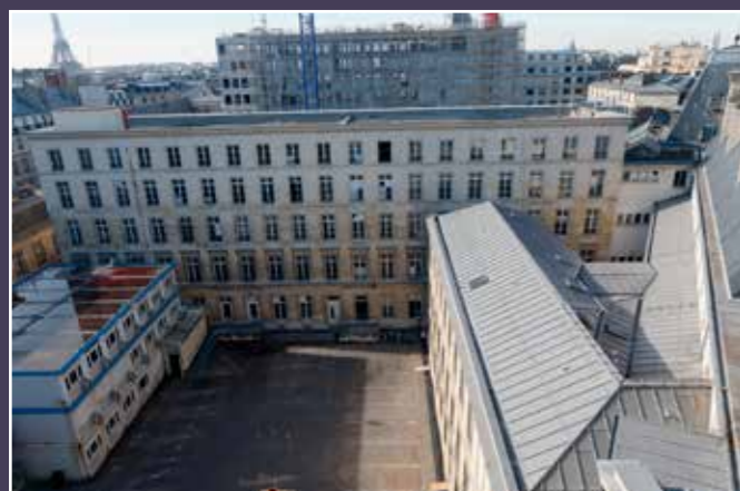
Vue de la cour de la bibliothèque.
