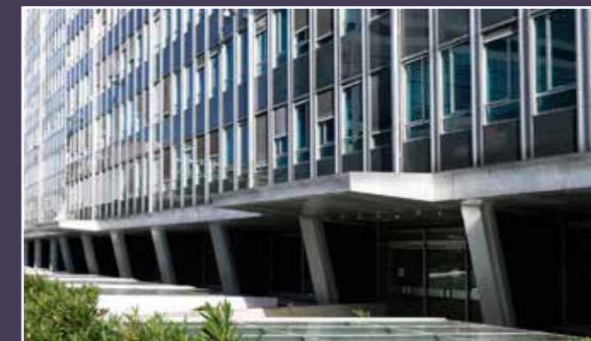
Vue de la façade arrière côté Jardin de l'Atlantique et accès à la barre CNP.
