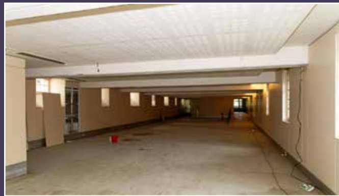
Vue de la sous-terrasse ouest.
