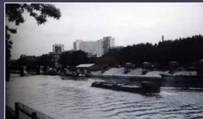
Vue des quais avant la rénovation (Archives de Paris).
