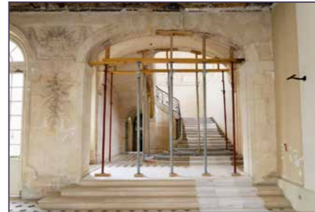
Vue actuelle du vestibule et de la cage de l'escalier d'honneur, avec étaie.
