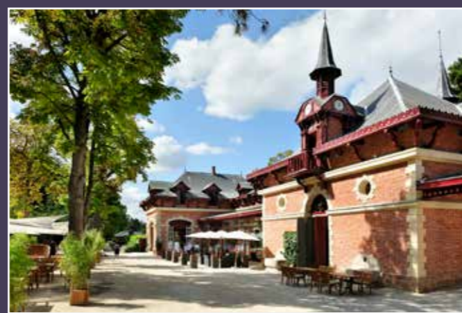
Vue du pavillon du côté de la terrasse.
