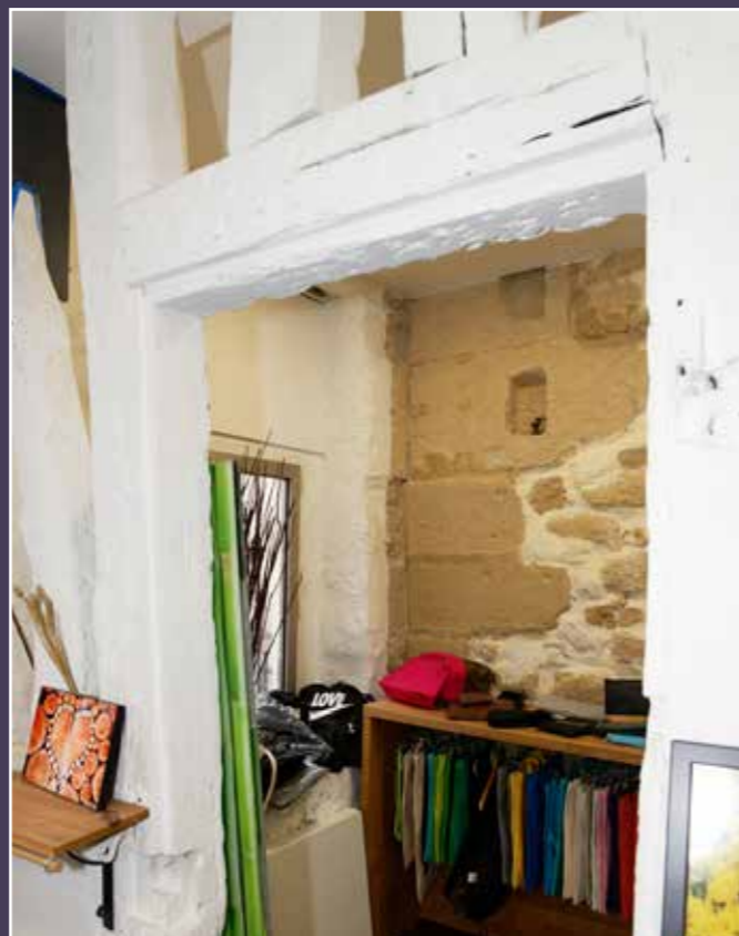
Vue de la structure du réservoir dans l'actuelle boutique à rez-de-chaussée.
