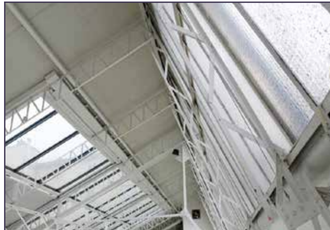
Vue de la structure en métal et des sheds en 2017.
