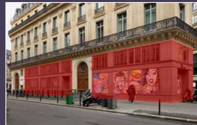
Vue avec indication des démolitions prévues pour la façade de la rue Meyerbeer (© Wilmotte & Associés).
