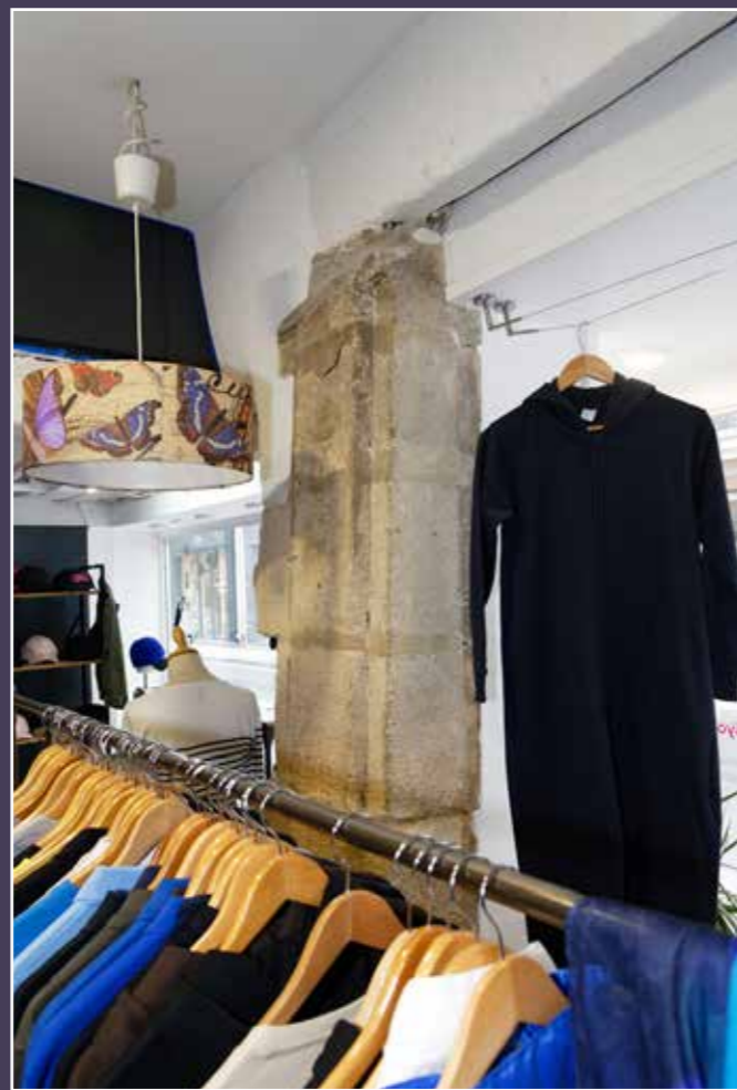
Détail du piédroit de l'ancienne porte de l'église des Enfants-rouges formant vitrine de l'actuelle boutique.
