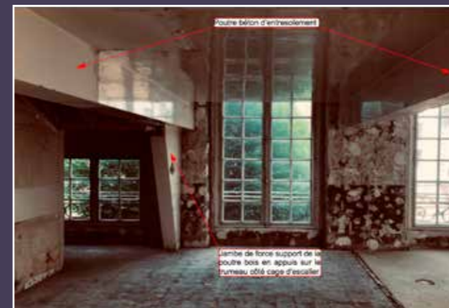
Vue de la mezzanine et des poutres en béton (© cabinet Jean Charpentier).
