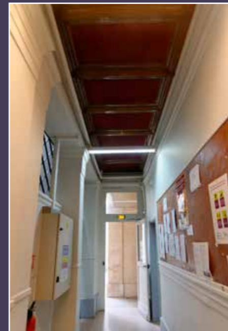
Couloir entre le bâtiment intermédiaire et les salles sud.
