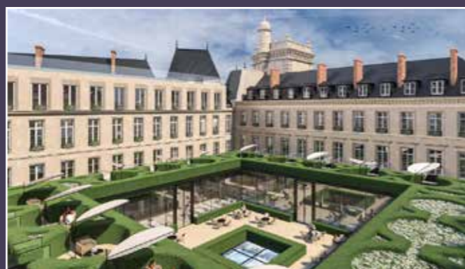
Vue d'insertion, cour de la bibliothèque (© COS architectes).
