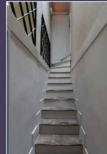
Escalier conduisant au niveau supérieur de la galerie.
