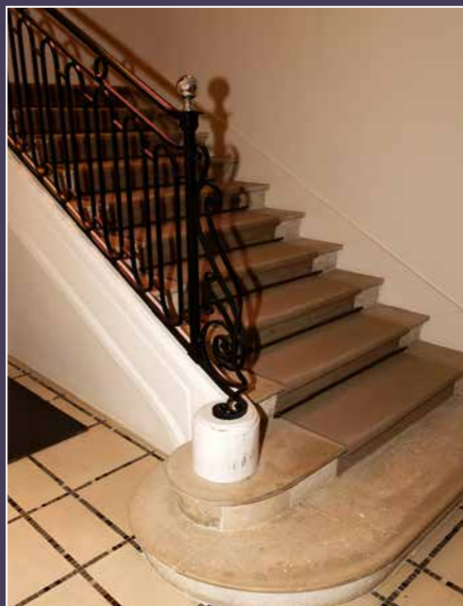
Vue actuelle de l'escalier principal.
