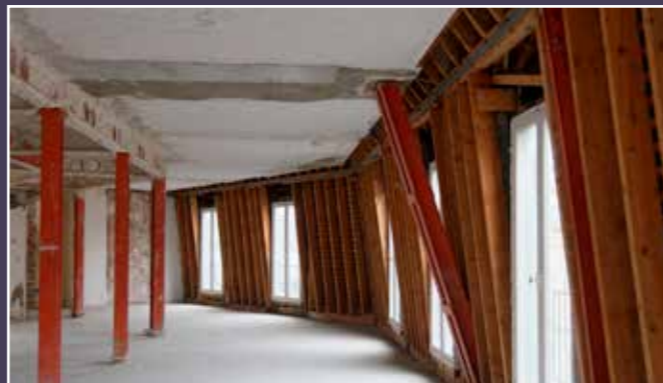
Vue actuelle du plateau à R+4 avec la structure du brisis, suite à curage.
