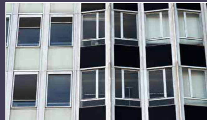
Détail de la façade principale, à la jonction des deux types d'élévation.
