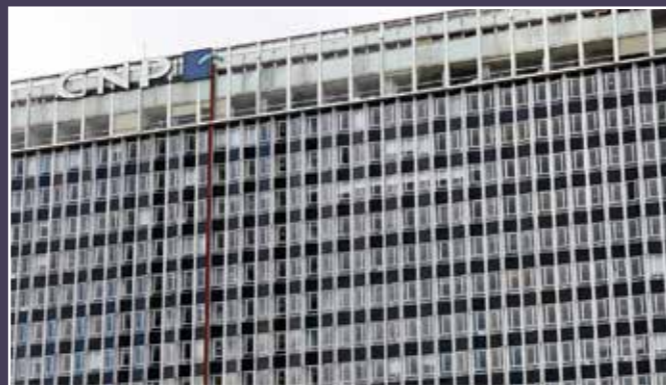
Vue de la façade principale sur la place Raoul Dautry.
