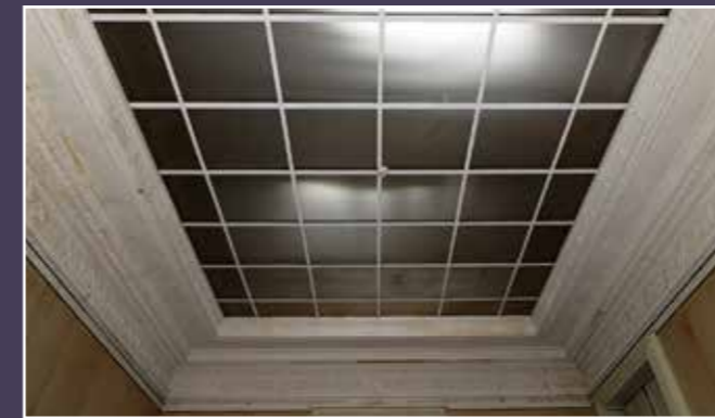
Trianon, vue d'un des faux plafonds.
