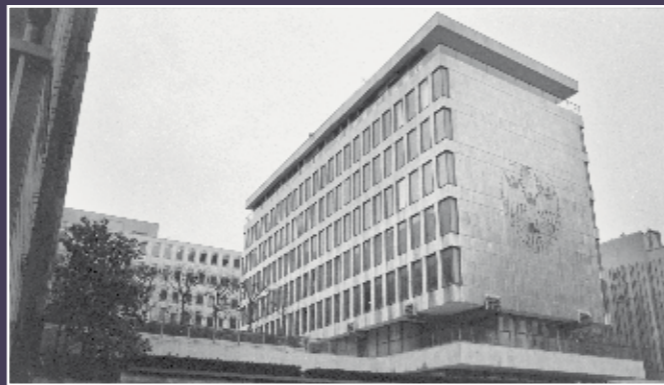
Vue depuis la rue Laffite avant rénovation, 1972 (Casier archéologique).
