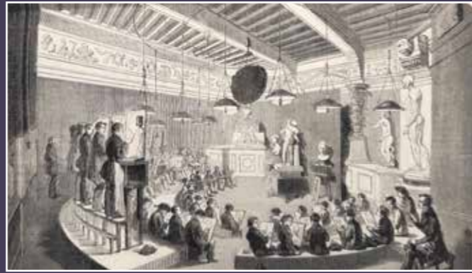
Salle de cours (bâtiment intermédiaire?), av. 1877.
