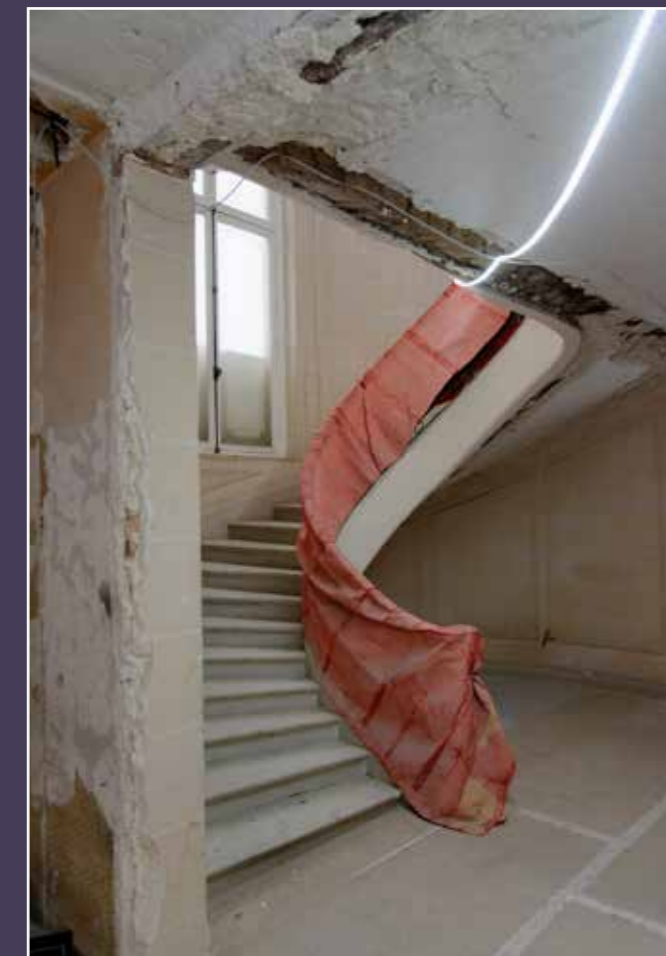
Escalier principal au 14, rue Halévy, lors des travaux de curage en septembre 2020.
