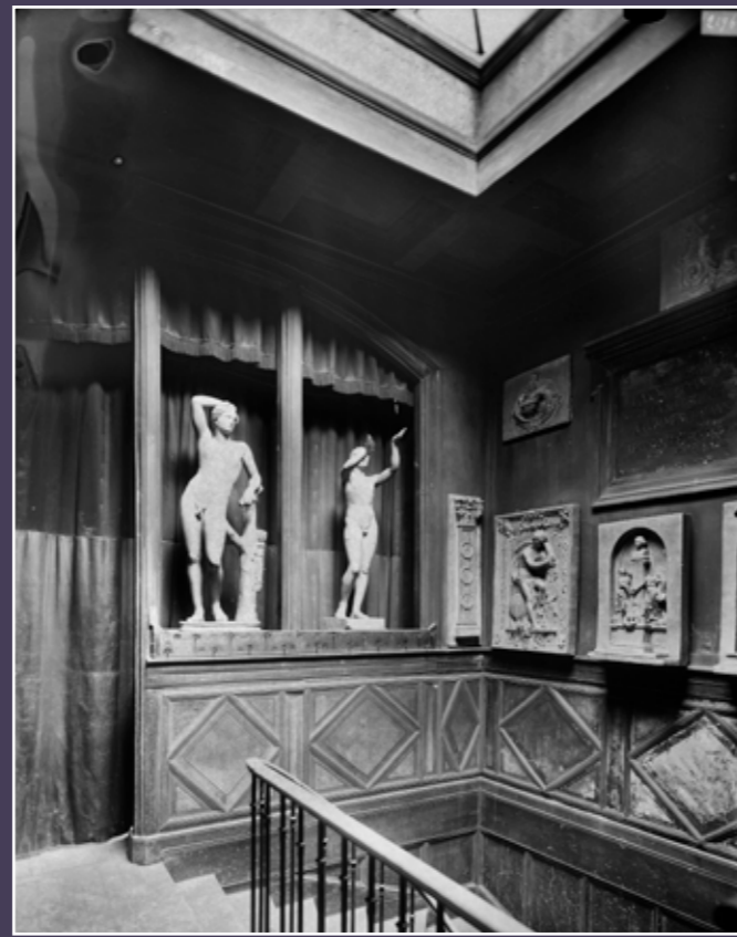
Vue au dernier niveau de l'escalier, 1918 (Casier archéologique).
