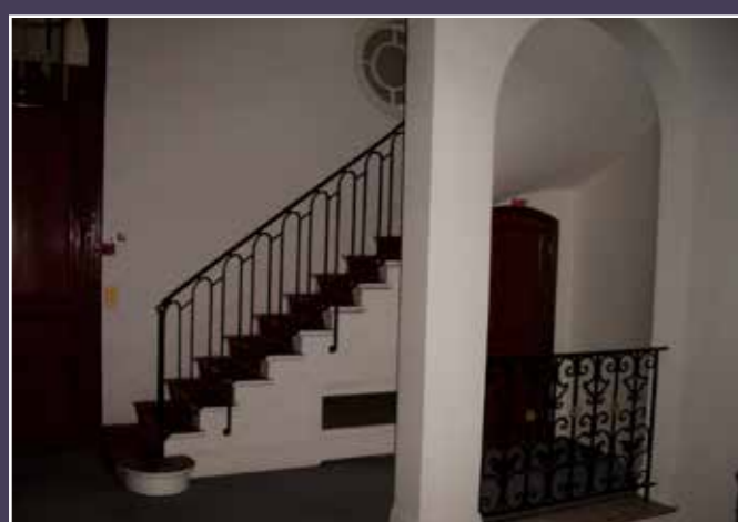
Vue de l'escalier de service avant les travaux de réaménagement de 2009.
