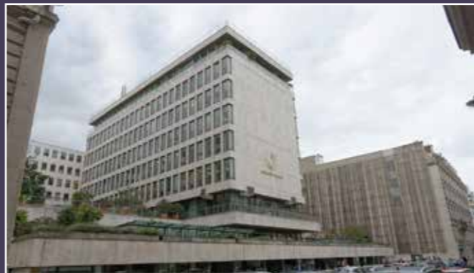
Vue en 2015 depuis la rue Laffitte en direction du pignon nord.
