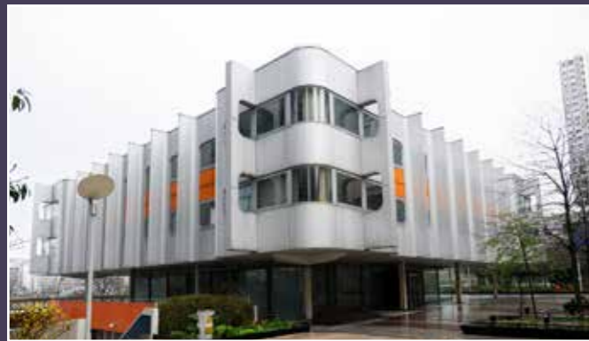
Vue actuelle depuis la dalle.
