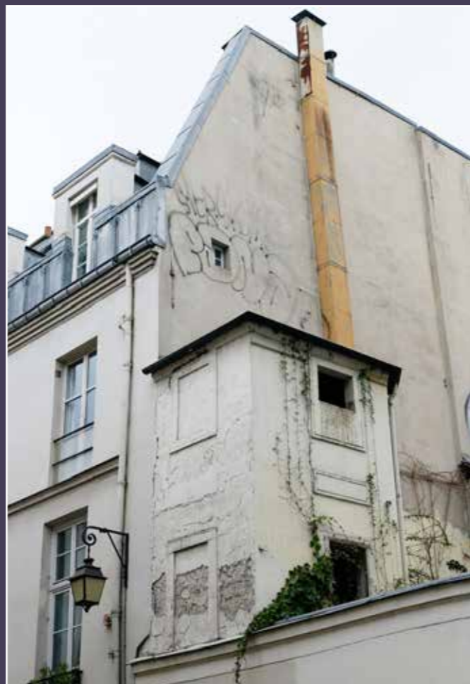
Vue des deux étages du réservoir d'eau.
