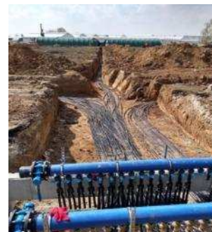
Forages et collecteurs des sondes géothermiques Centre de Production horticole de Rungis (94)
