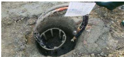
Géothermie sur pieux , Gymnase Madeleine Rebeyrioux 75018
