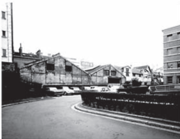
Entrepôts rue Boissonade avant démolition
