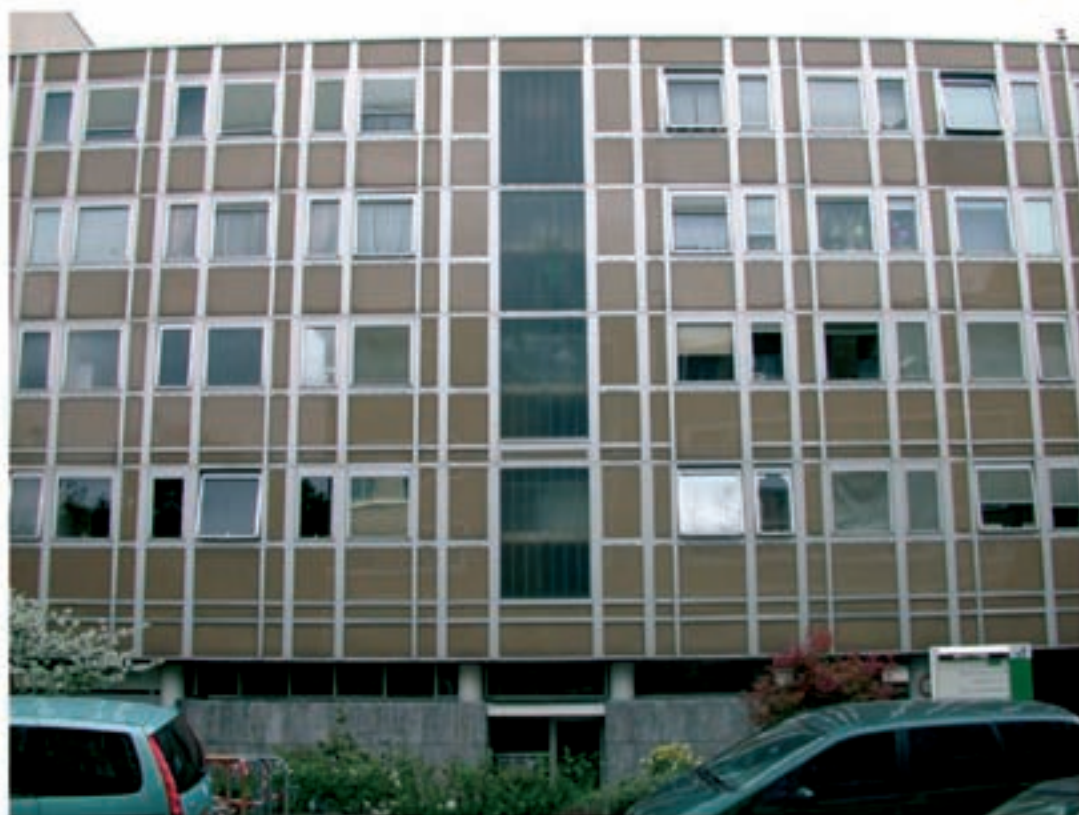
Façade sur cour
