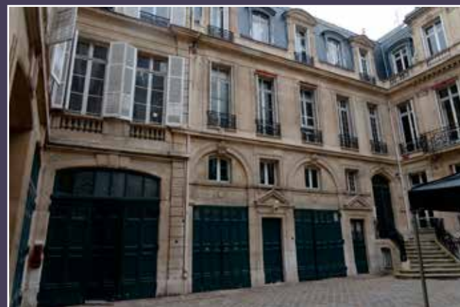
Vue de l'aile nord sur cour.
