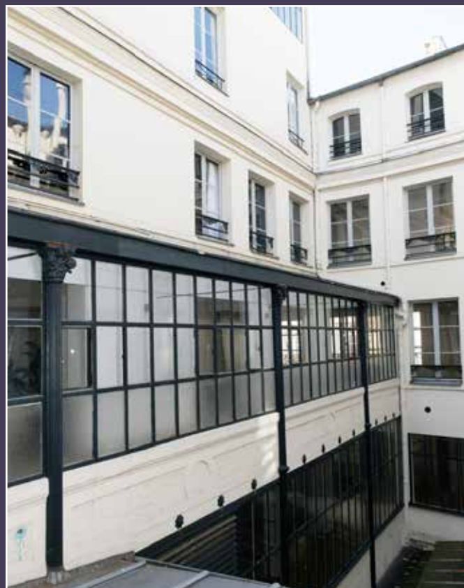
Vue de la galerie vitrée.
