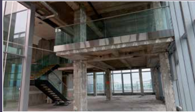
Vue du dernier étage dont le plancher a été partiellement démoli en 2006, photographié en 2021 lors du curage.
