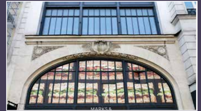
Détail de la façade actuelle.
