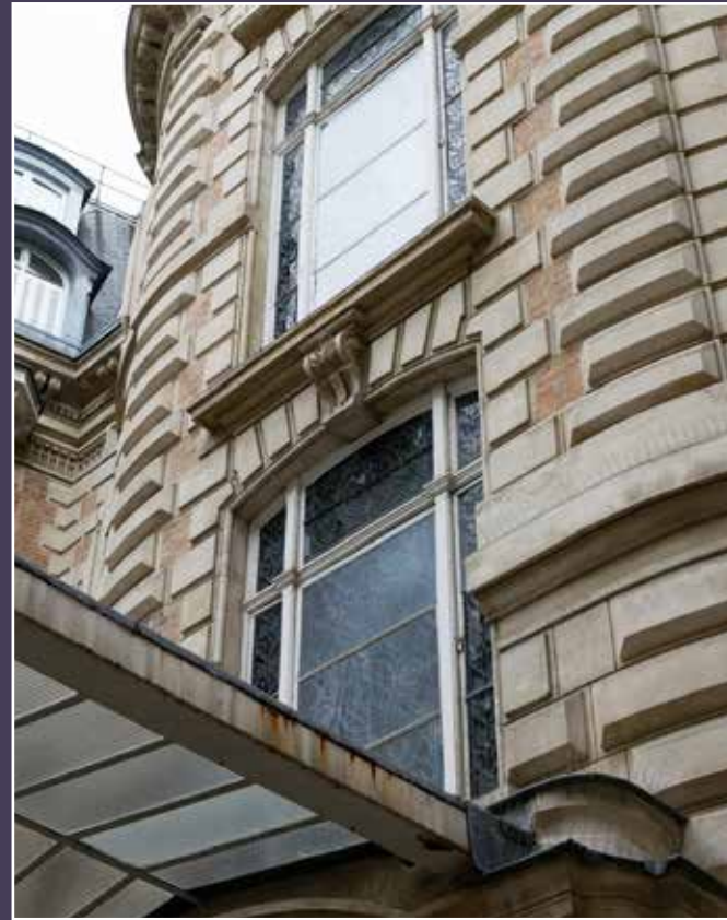
Vue actuelle des baies de l'escalier.
