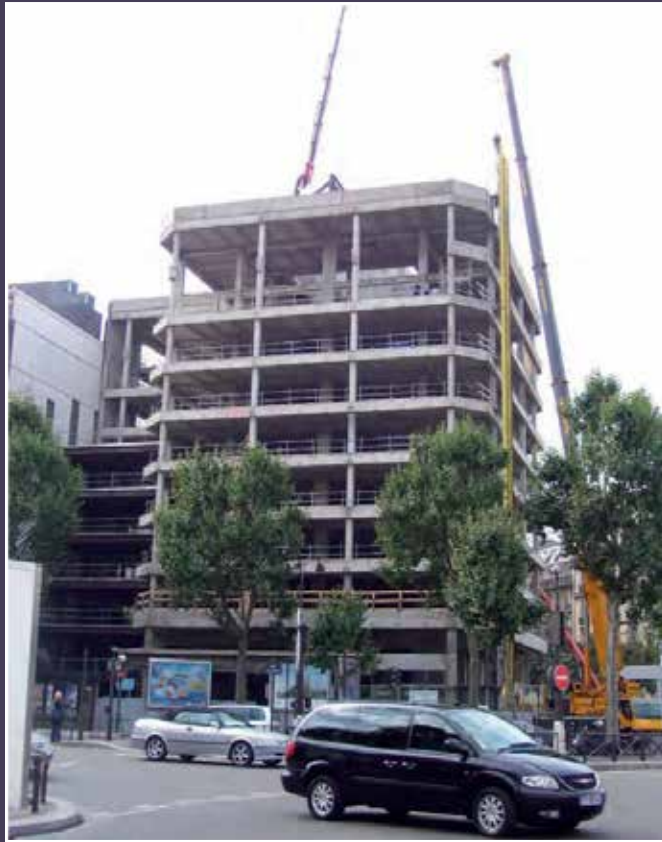
Restructuration de 2006 (© Grahall).
