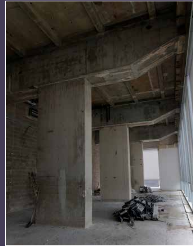
Vue actuelle des superstructures du rez-de-chaussée.
