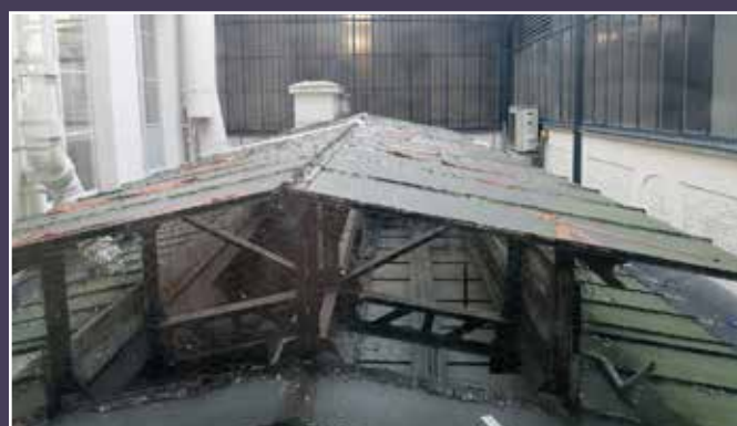
Détail de la verrière de la cour.
