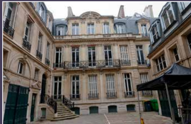
Vue de l'hôtel en fond de cour.
