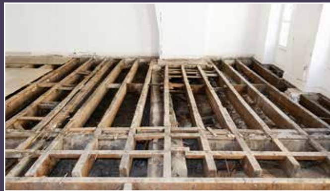
Vue des sondages réalisés au R+2.
