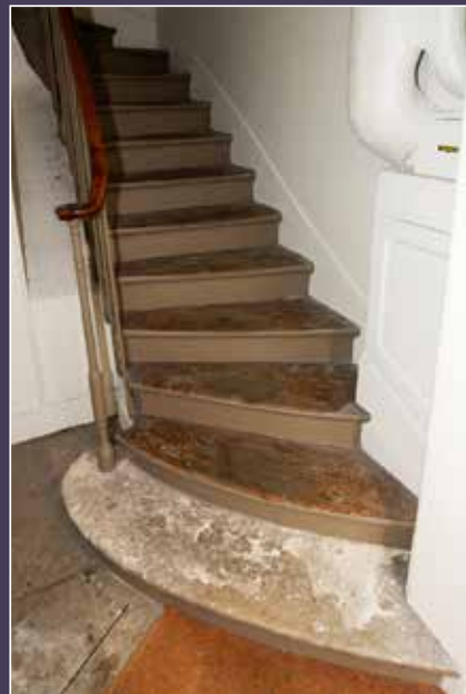
Vue de l'escalier de service ouest.
