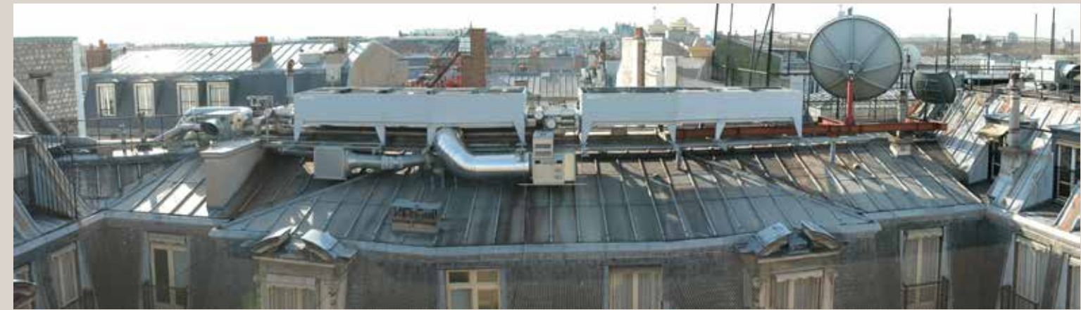
Vue actuelle des installations techniques disposées en toiture qui doivent être déplacées au 2 nd sous-sol.
