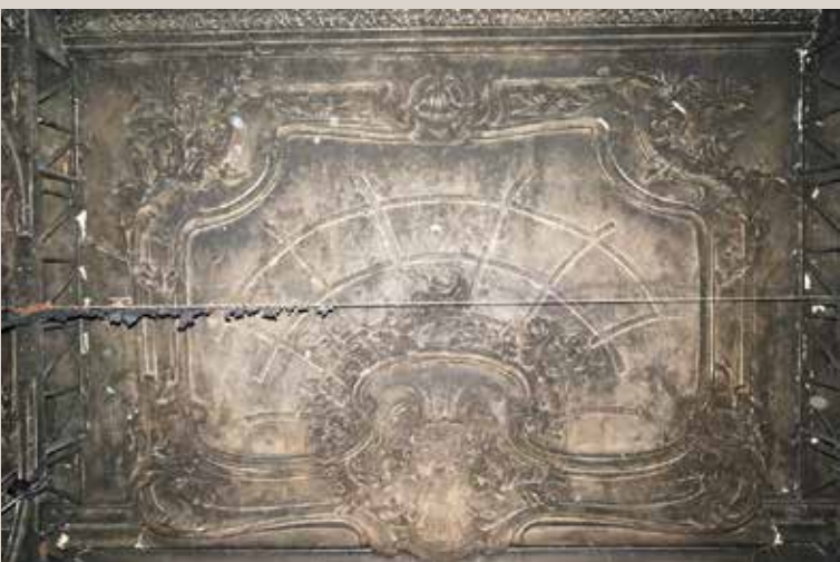
Exemple de vestige du décor en plâtre de la couvrtue de la salle, qui servira de modèle pour la recréation de l’ensemble.
