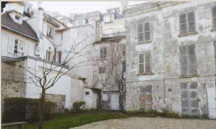
Ci-contre, à gauche : vue existante du corps de bâtiment actuellement en retrait du pavillon néo-classique, qui s'adresse au n°8, rue Cortot.
