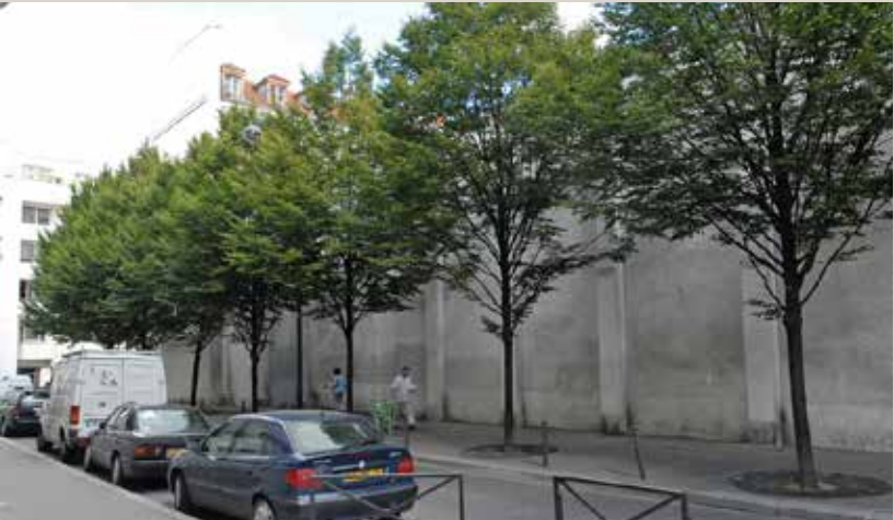
Vue du mur de clôture le long de la rue Paul Laurent. Ce mur serait percé donnant accès au bâtiment projeté.
