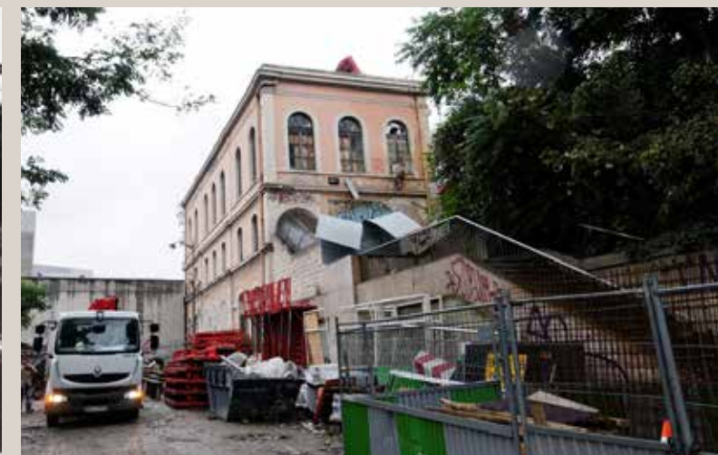
Vue actuelle. À gauche figure l'ouvrage de recouvrement des voies du faisceau Austerlitz.
