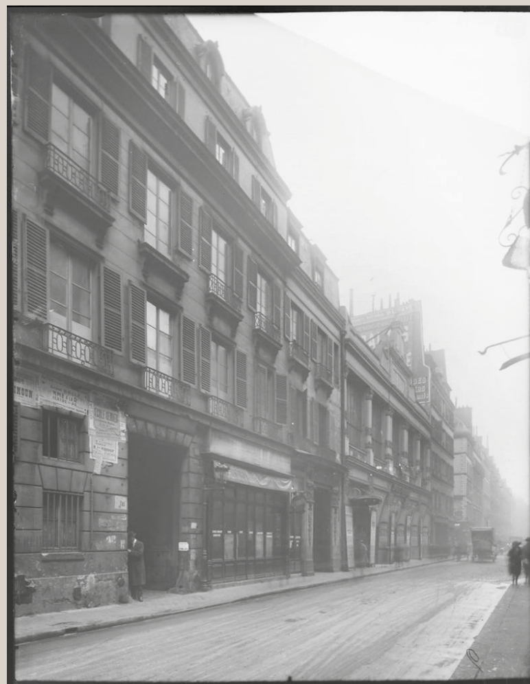
Vue de l'immeuble (et des anciennes Folies Bergère) en 1919 (cliché Lan-siaux, Casier archéologique).
