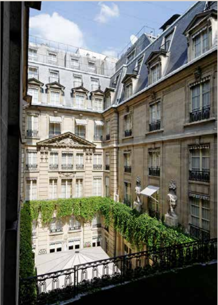
Vue actuelle de la première cour, dite cour d'honneur.
