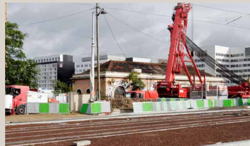
Vue actuelle de l'ancienne station Orléans-ceinture depuis le boulevard du Général Jean Simon montrant les travaux en cours d'extension du tramway.
