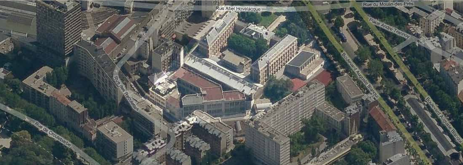
Vue à vol d'oiseau montrant la partie basse de l'école construite à partir de 1934 donnant sur la rue des Reculettes, le corps de bâtiment intermédiaire regroupant les ateliers et la composition en U initiale adressée sur le boulevard Auguste Blanqui au sud.
