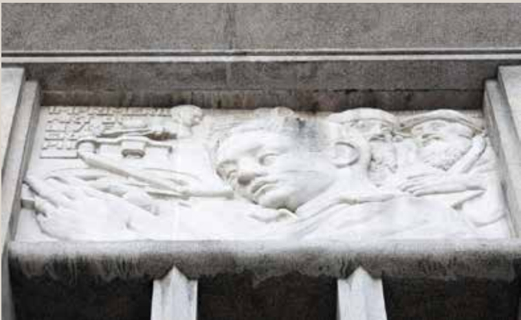
Détail d'un des trois bas-relief ornant le registre haut du corps central du bâtiment des années 1930.
