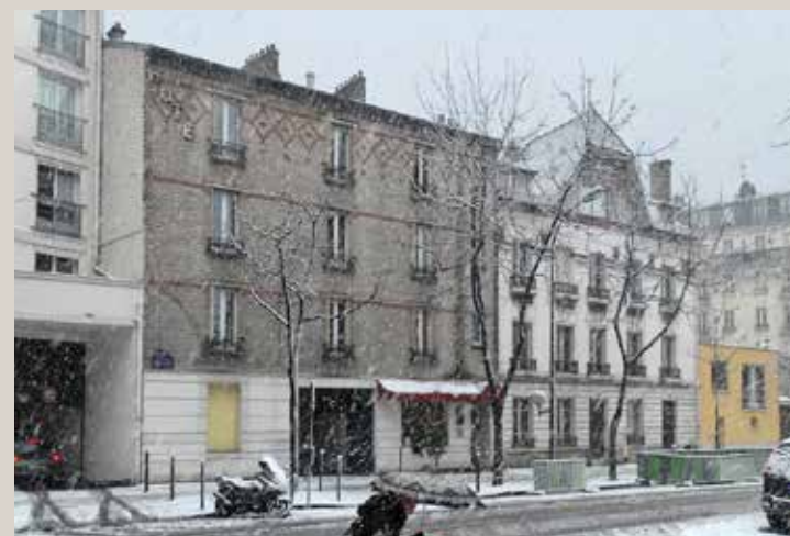
Vue actuelle avec, à gauche, la façade de brique de l'hôtel meublé du n°76 et à droite, les habitations du n°74-74B.
