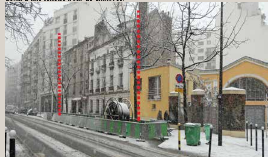
Vue actuelle depuis l'angle de l'ensemble des n°72, 74-74bis et 76, avenue Félix Faure. À l'angle (n°72), la démolition du patronage laïc a déjà été examinée en CVP.
