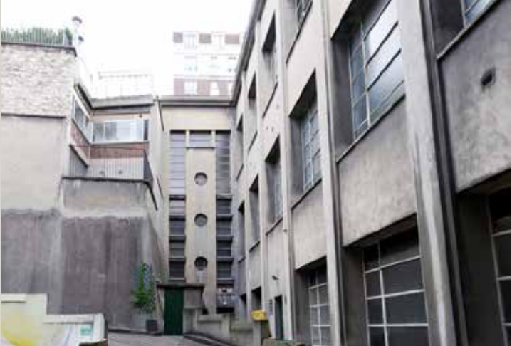
Vue du retour de la façade sur cour abritant les paliers de distribution intérieure du second escalier de l'ensemble années 1930.
