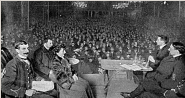
Réunion des grévistes du magasin Dufayel le 23 décembre 1905 dans la salle de l'Élysée-Montmartre, dont on reconnaît la structure métallique.
