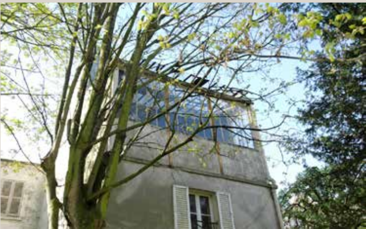
Vue de l'atelier de peintre du n°12, rue Cortot, qui serait réhabilité.
