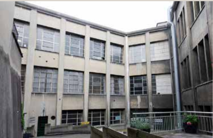
Vue sur la cour du bâtiment des années 1930. La plupart des grandes baies des salles de cours conservent leurs menuiseries d'origine.
