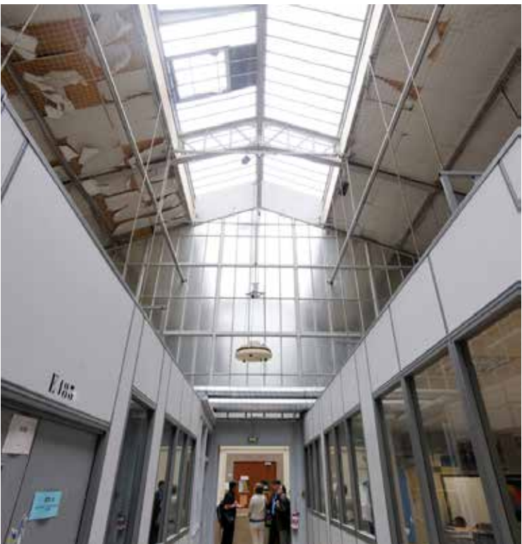
Vue actuelle intérieure du bâtiment intermédiaire à usage d'atelier.
