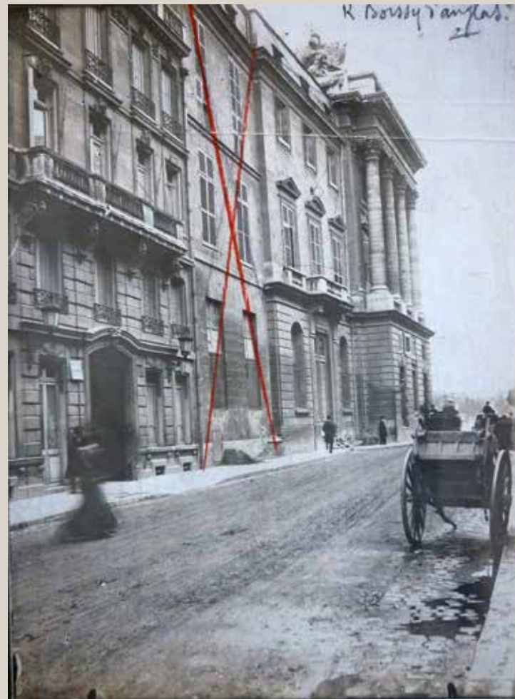
Photographie de la façade XVIII e siècle en retour sur la rue Boissy d'Anglas jointe à la demande de permis de construire de 1909 qui indique de la partie à démolir. Au premier plan, l'immeuble de 1877 avant transformation (Archives de Paris).
