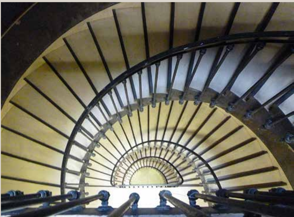
Vue actuelle de l'escalier desservant les logements de fonction situés dans le pavillon à l'angle des rues Jean-Jacques Rousseau et Étienne Marcel (dont la conservation est prévue).
