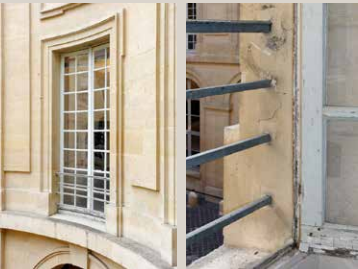
Vue actuelle d'une croisée du premier étage côté cour, et détail des lisses actuellement en place.
