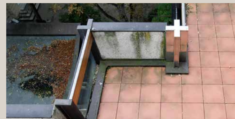
Émergence sur la terrasse du troisième niveau d'une des piles cruciformes dont l'implantation répond à une logique de tracé régulateur.
