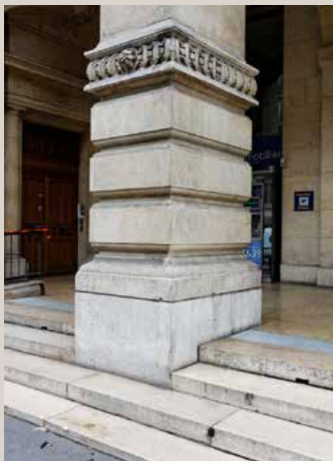
Détail de l'embranchement de l'entrée principale.
