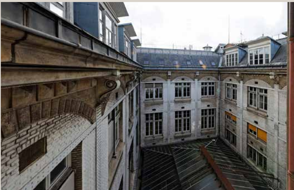
Vue actuelle de la cour côté rue du Louvre dont la verrière permettait d'éclairer l'arrière des guichets du hall. La plupart des fenêtres sont d'origine.
