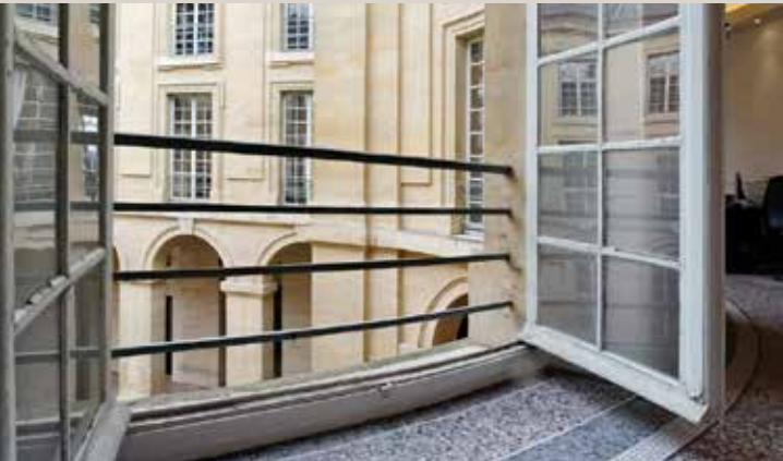
Détail des garde-corps actuellement en place au premier étage du corps principal, côté cour. Deux des quatre lisses sont en fer forgé.
