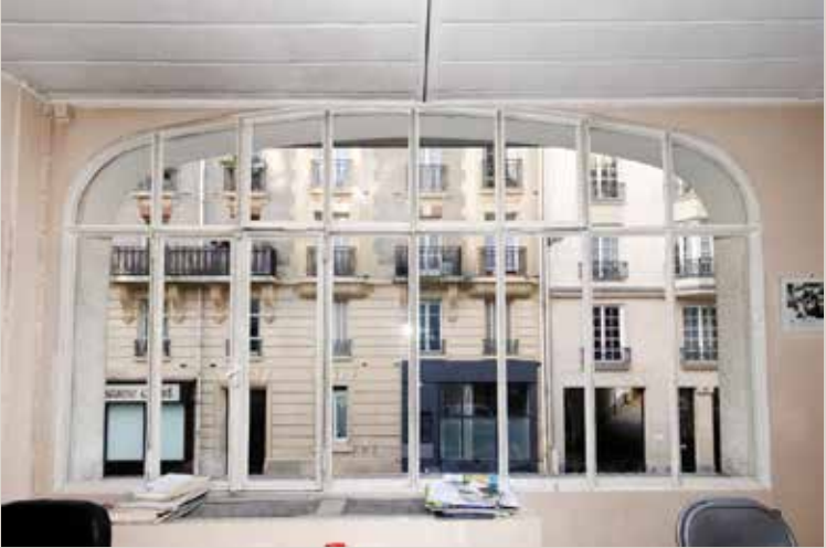
Fenêtres des bureaux du premier étage.
