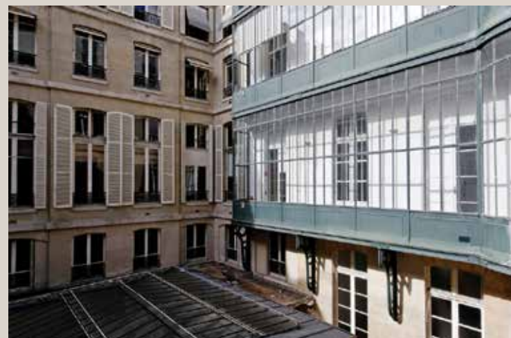
Vue de la cour du n°31 montrant la structure métallique du XIX e siècle.
