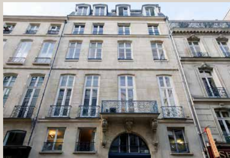
Façade du n°31, rue Danielle Casanova.
