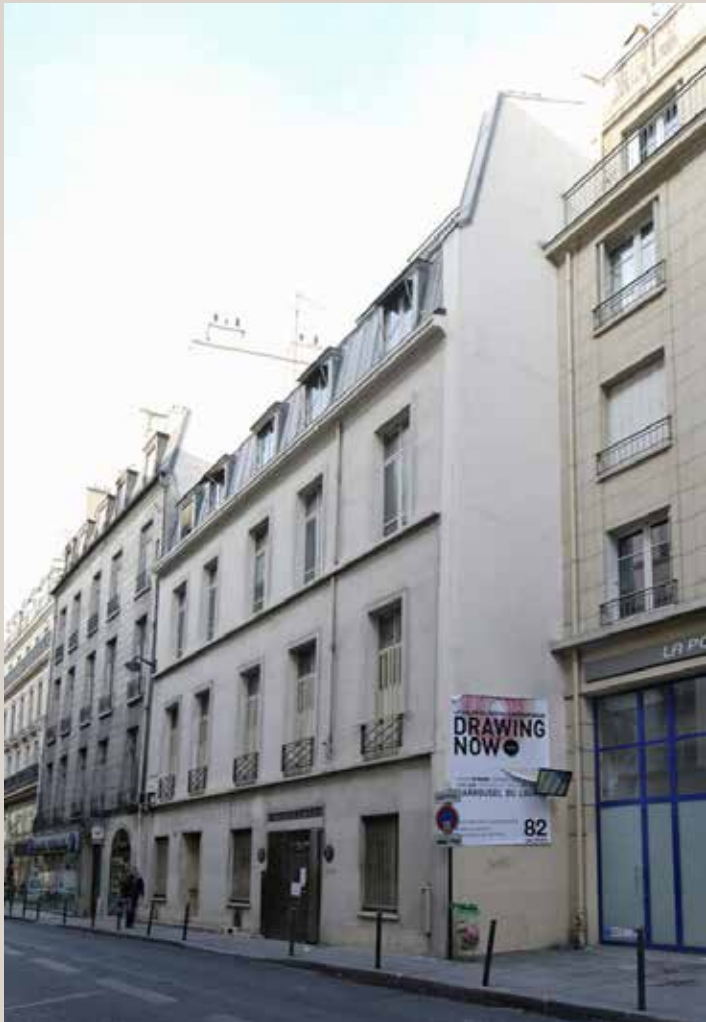
Vue actuelle de la façade.
