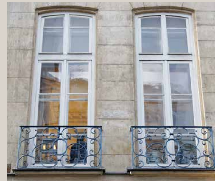
Détail des fenêtres sur rue du n°31, rue Danielle Casanova, au premier étage.
