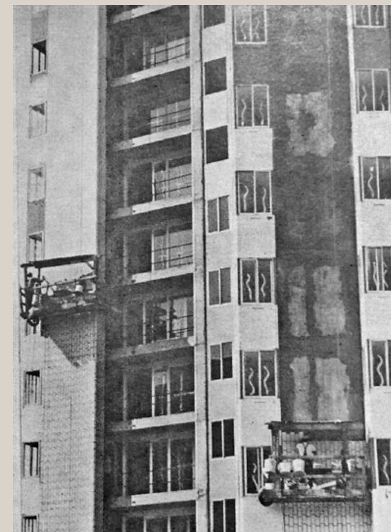
Vue du revêtement céramique en cours de pose ( Bâtir , n°29, mars 1974). La tenue de ce revêtement avait fait l'objet d'une étude spécifique par le fabricant.
