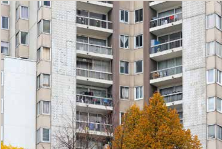
Vue rapprochée de la façade d'une des tours. Le parement présente des défauts d'aspect et les menuiseries extérieures ont déjà été remplacées.
