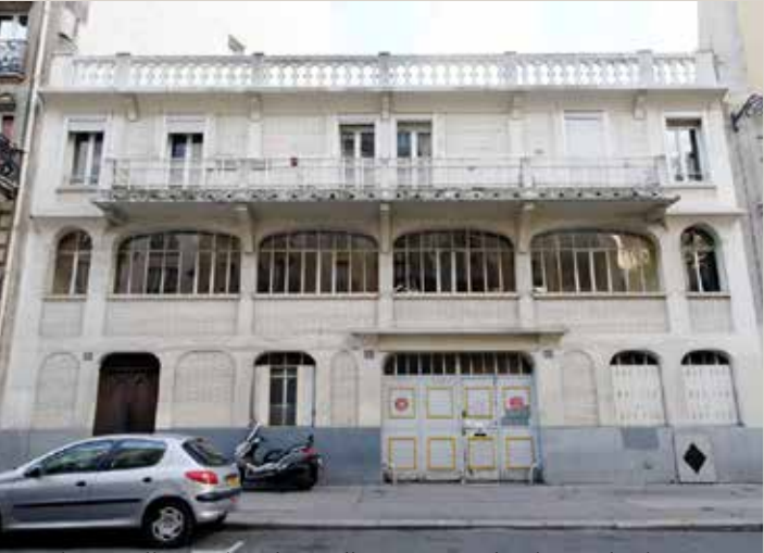
Façade actuelle : en bas, les ateliers, au premier étage, des bureaux, et au dernier étage, un logement.
