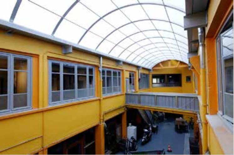
État actuel de la cour couverte. Le permis de construire d'origine mentionne une charpente de béton portant une verrière.
