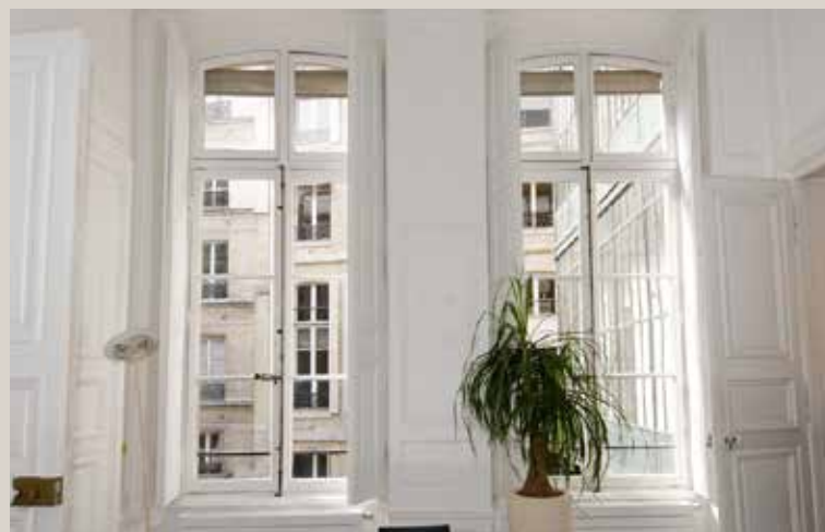
Vue des fenêtres sur cour du n°31.
