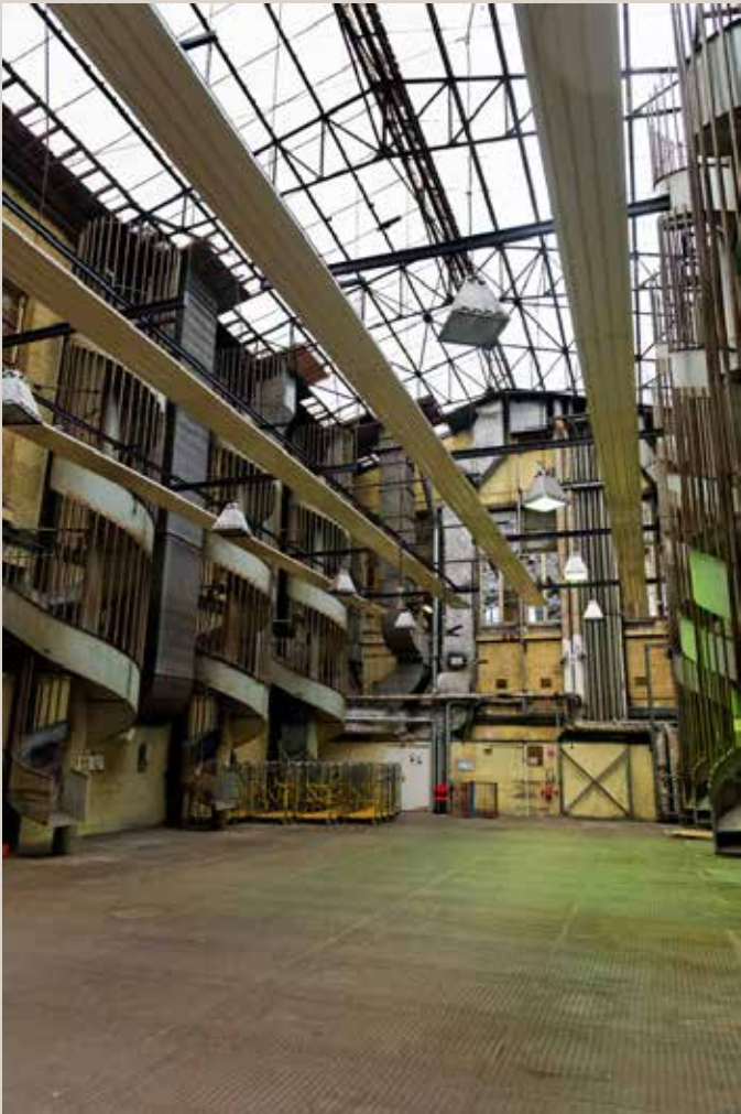
Vue actuelle de la cour couverte avec les fameux toboggans résultant de la mécanisation de la manutention mise en place après-guerre.
