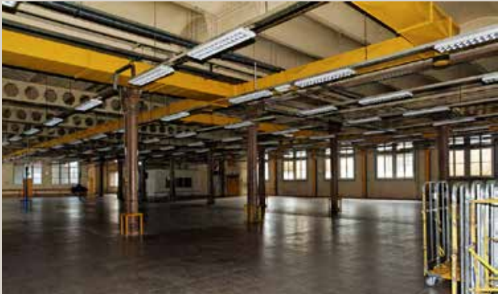
Vue actuelle du plafond du 2 e étage avec la nouvelle charpente.
