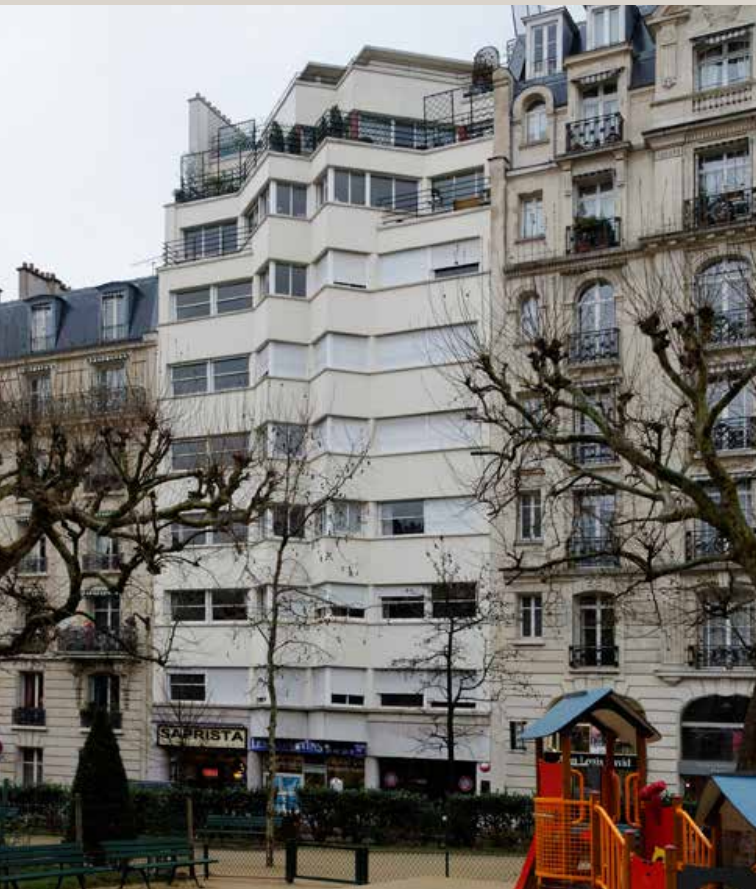
Vue générale de la façade actuelle sur la place.
