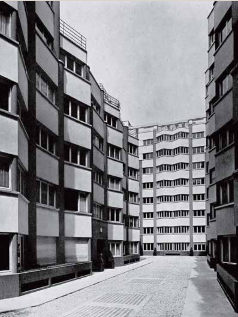
Vue des façades en cœur d'îlot à la livraison du bâtiment (publié dans L'Architecture d'aujourd'hui , n°5, 1934).
