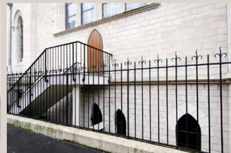
Détail de l'issue de secours existante et de son escalier.
