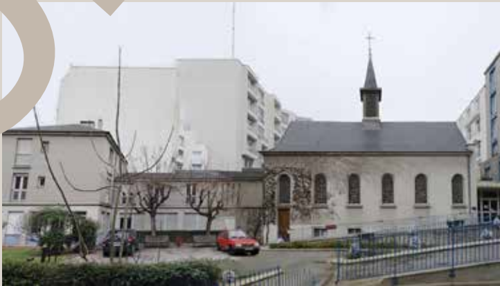
Vue actuelle des bâtiments sur cour. À gauche, le bâtiment sur rue, la chapelle au centre et la maison de retraite à droite.
