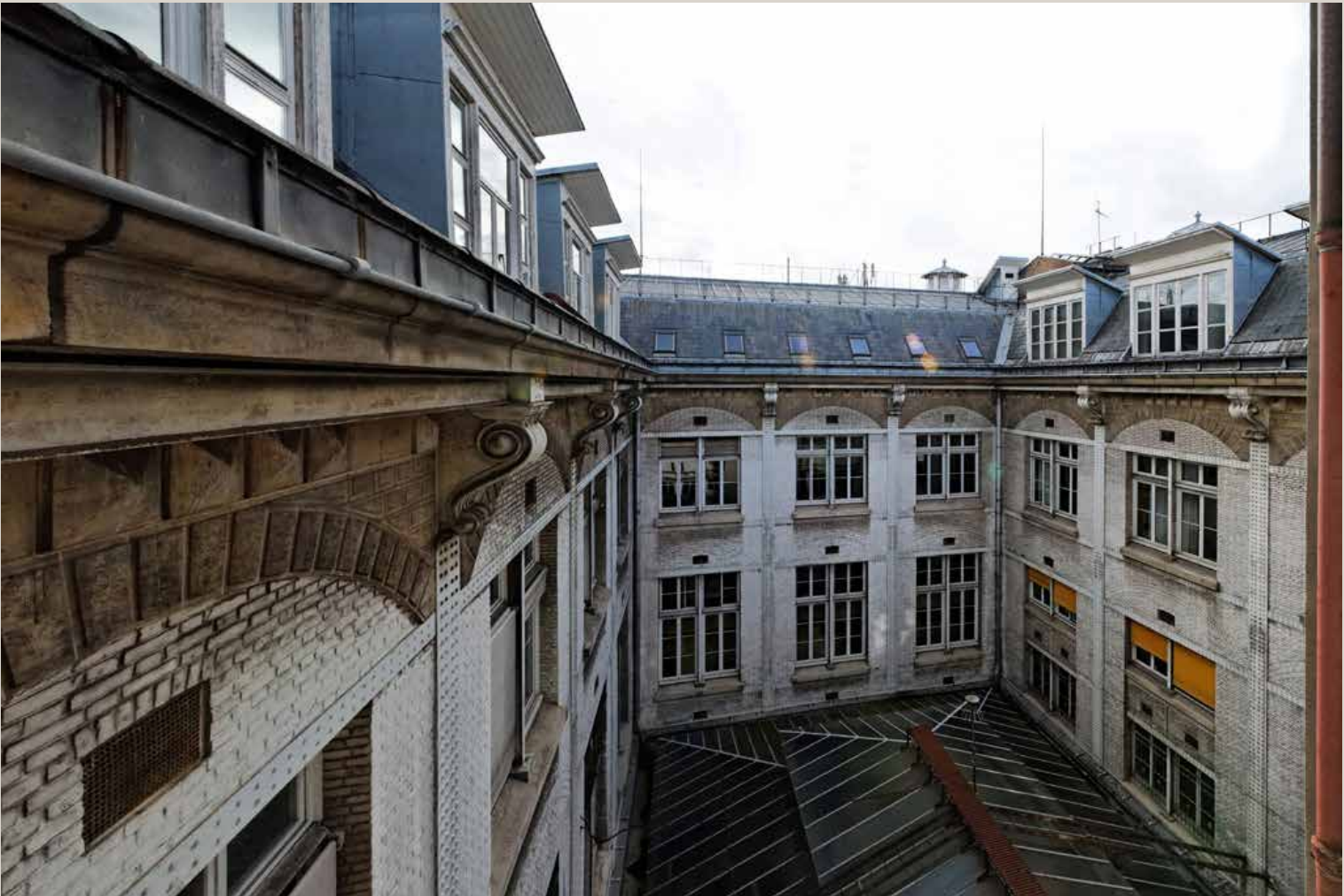
Vue actuelle de la cour côté rue du Louvre dont la verrière permettait d'éclairer l'arrière des guichets du hall. La plupart des fenêtres sont d'origine.
