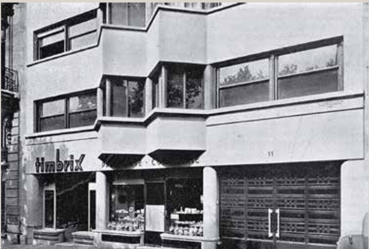
Détail de la façade sur la place (publiés dans La Construction moderne , n°42, 15 juillet 1934).
