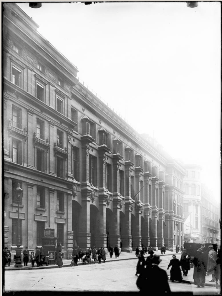
Ci-contre : vue de l'hôtel des Postes rue du Louvre (cliché Lansiaux, 27 octobre 1917).
