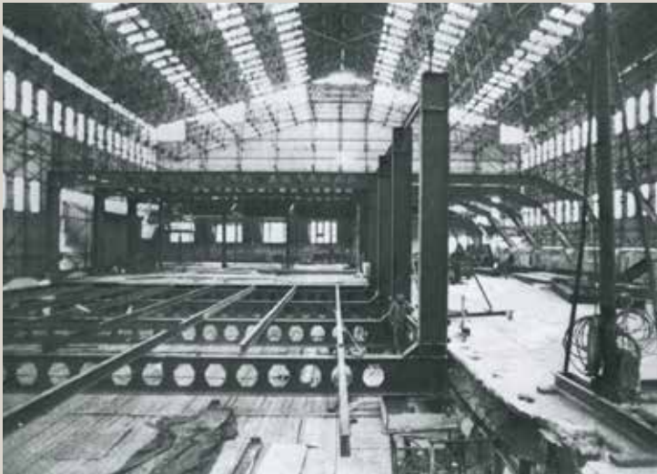
Vue du chantier de reconstruction des toitures vers 1979 suite à l'incendie de 1975 (coll. particulière).
