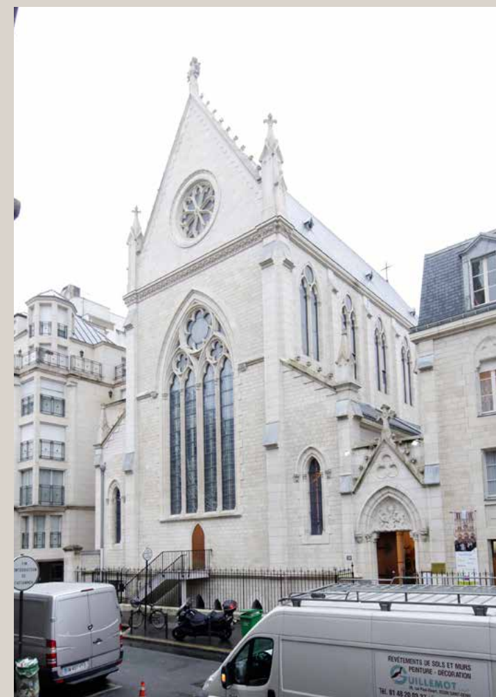
Vue actuelle de la façade.
