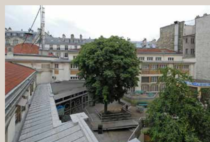
Vue actuelle de la cour arrière (angle sud-est).
