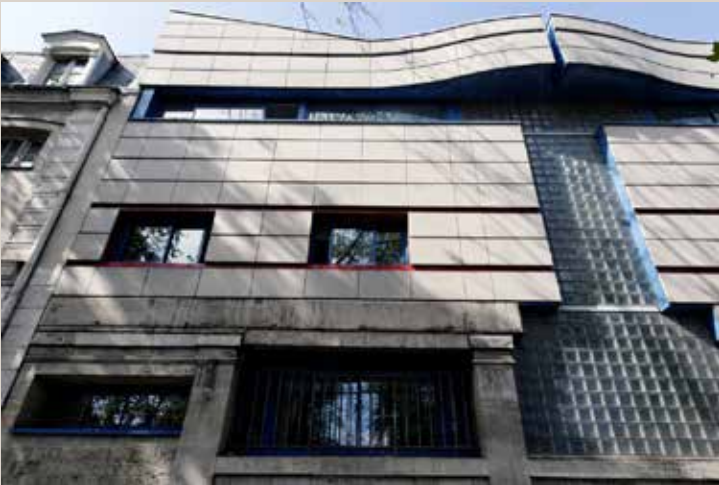
Vue du bâtiment des admissions et archives dit « Rapine » depuis l'avenue (Mauduit et Alluin, 1985).
