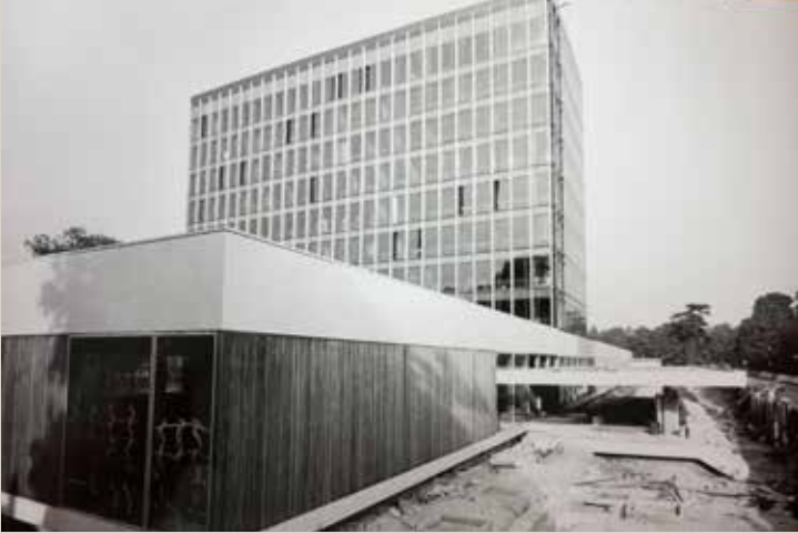
Vue de la façade sud et ouest lors du chantier (© IFA).
