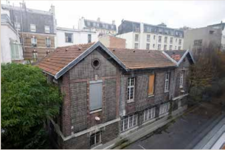
Vue actuelle du pavillon des rubéoleux convalescents (architecte Paul-Marie Gallois, 1886).
