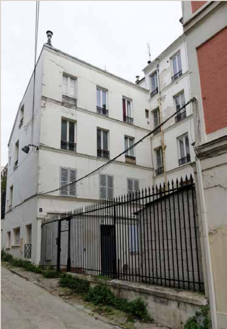
Vue de la façade sur cour du bâtiment C.
