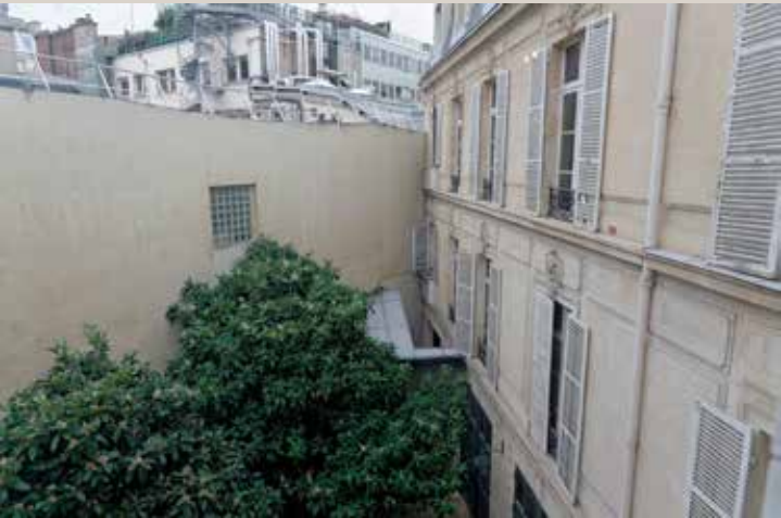
Vue actuelle de la façade de l’aile en retour.
