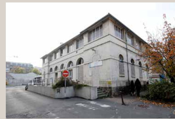
Vue actuelle de la buanderie désaffectée (1845).
