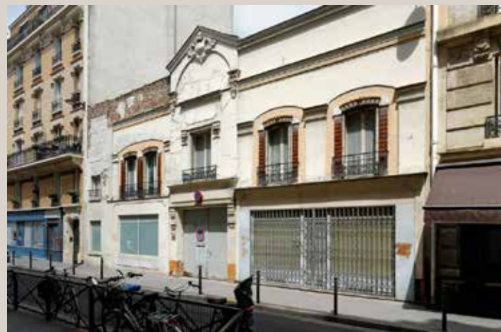
Vue actuelle de la façade sur la rue Letellier.
