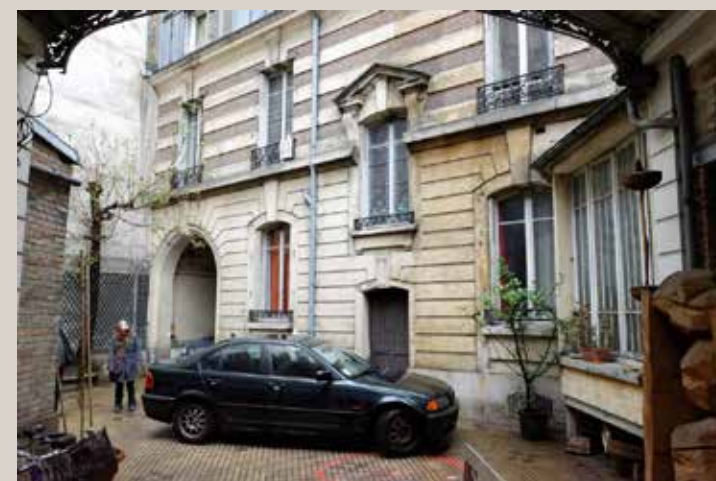
Vue de la façade arrière sur cour.
