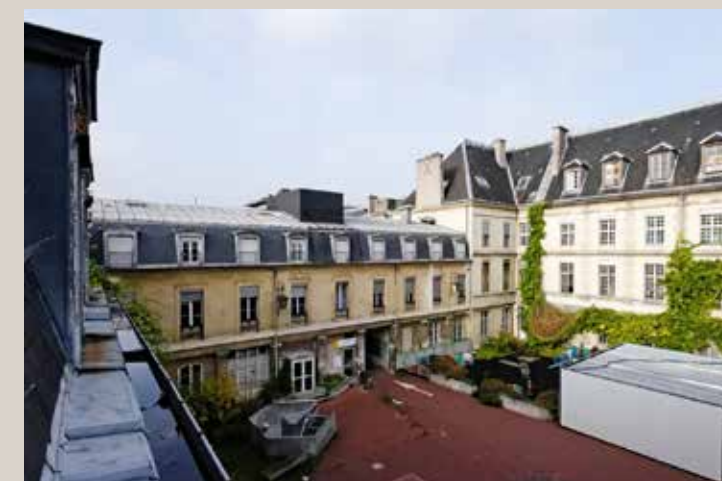
Vue actuelle de la cour des services généraux et du bâtiment Robin (1890).
