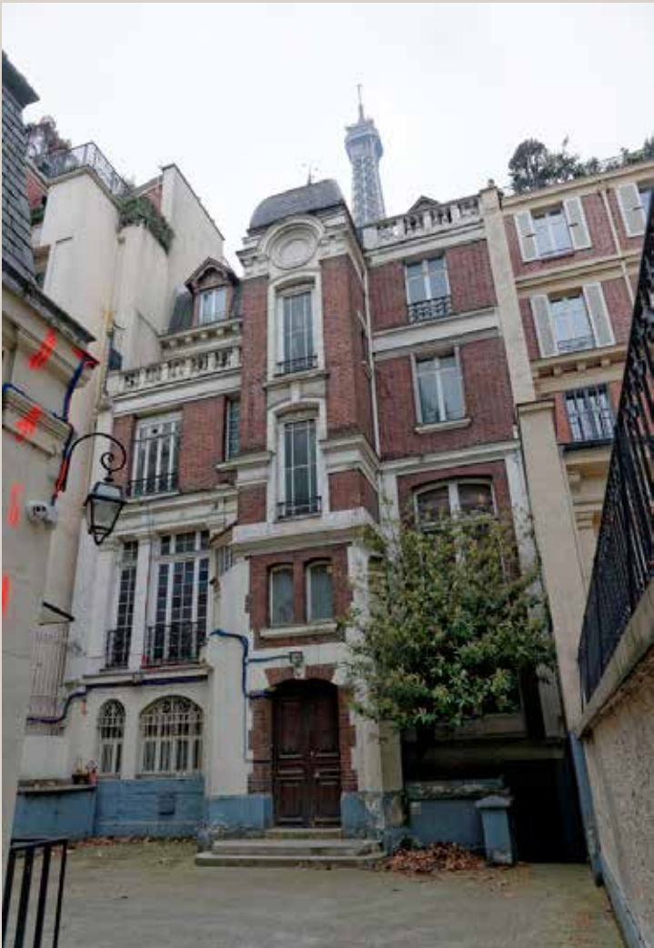
Vue actuelle du corps de logis principal depuis la cour.
