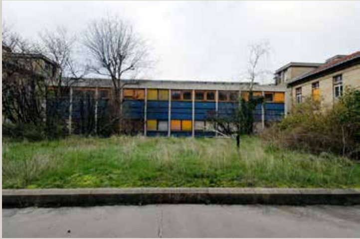
Vue de l'aile ajoutée en 1970 pour clore la cour de la maternité (Larrousse et Desprez).
