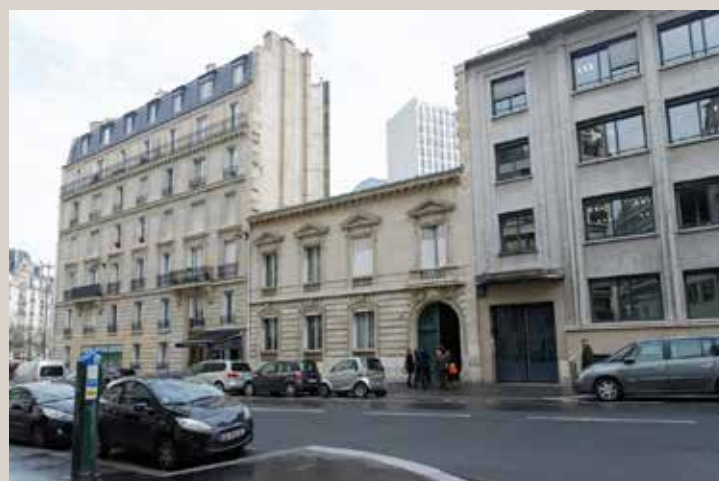
Vue actuelle depuis la rue de l'Armorique.
