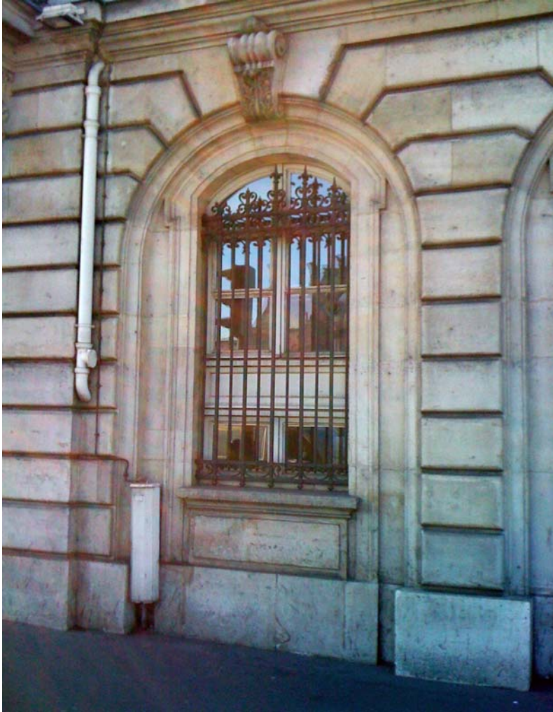
Ci-dessus : détail d'une des baies « à la Lescot » côté quai.
