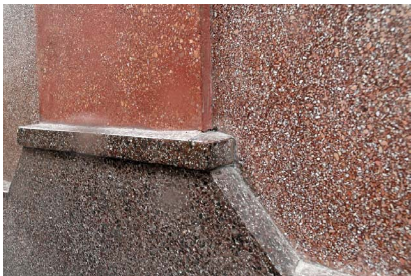
Ci-dessus : détails de la façade et du granito de revêtement.
