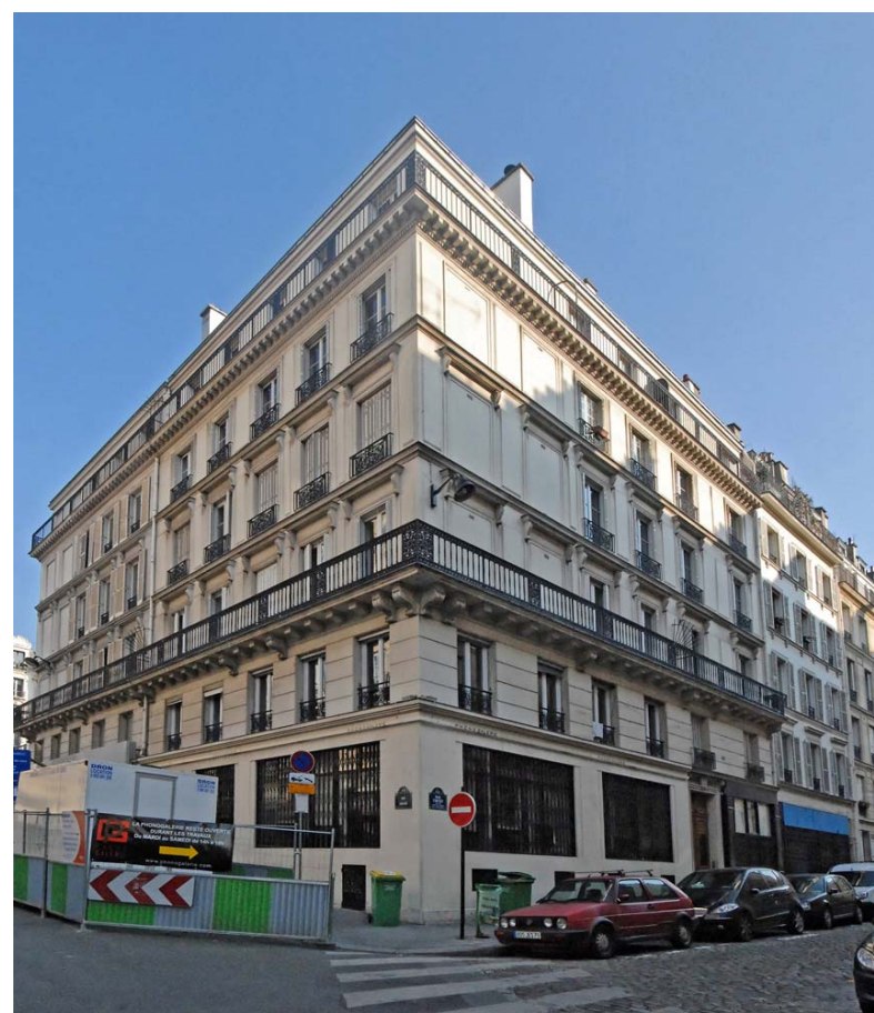
Ci-dessus : PLU ; façade sur le boulevard Rochechouart ; immeuble jumeau à l'angle des rues Lallier et Cretet.
