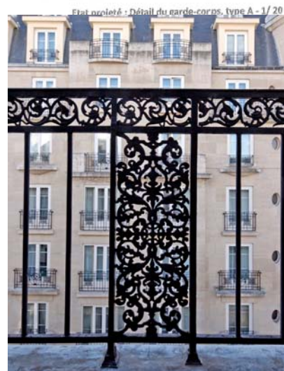
Ci-dessus, de haut en bas : mise au norme des garde-corps de balcon avec pose d'une résille métallique derrière le barreaudage existant.
