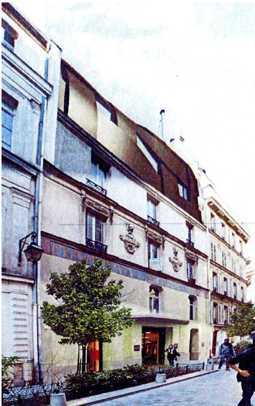
Ci-dessus : surélévation côté rue des Rosiers. Le comble constitué par une structure bois étanché et revêtu de lanières en cuivre.
