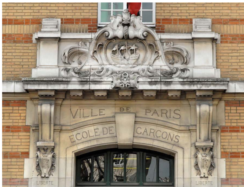
Ci-dessous : détail du portail d'entrée.
