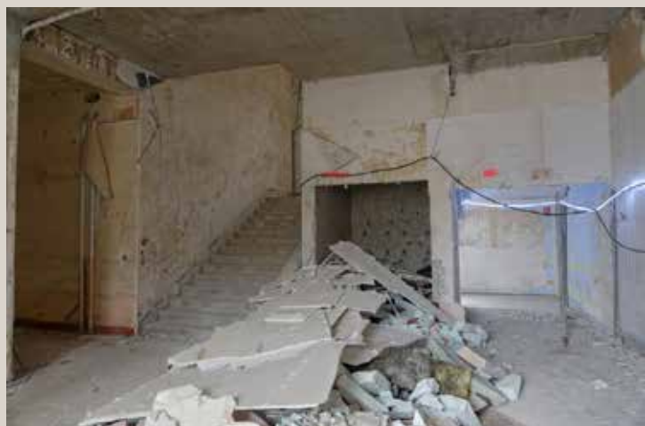
Vue des travaux de purge actuellement conduits à l'intérieur des bâtiments.
