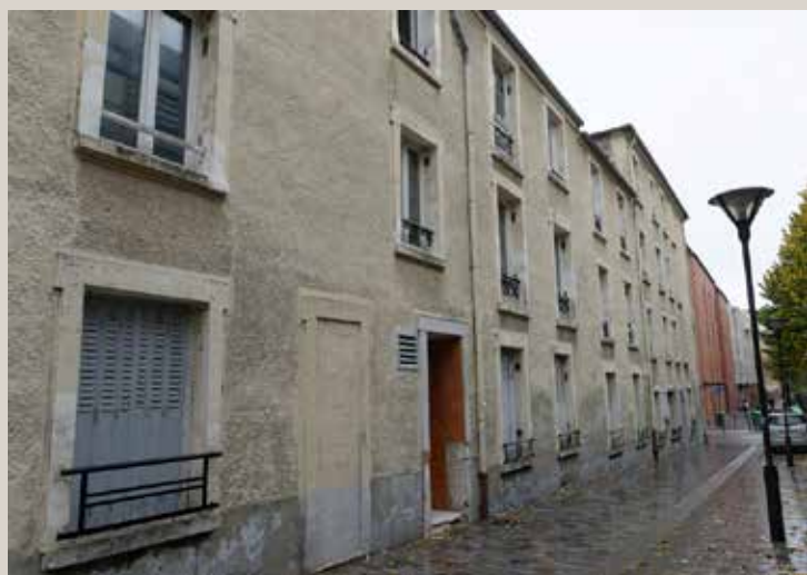
Vue actuelle des bâtiments depuis le passage Josseaume.
