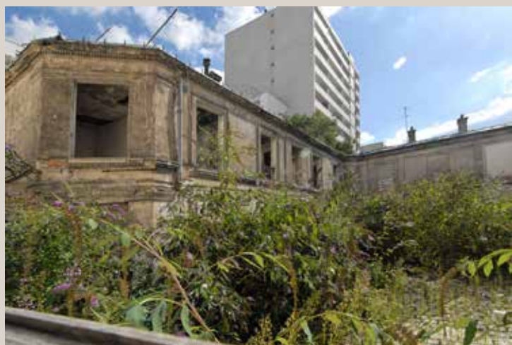
Vue des communs de la première cour, en 2010.
