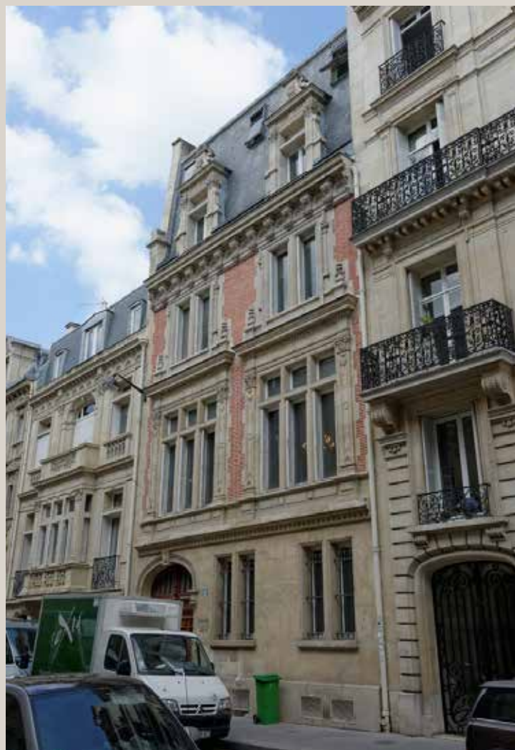
Vue actuelle de la façade sur rue.
