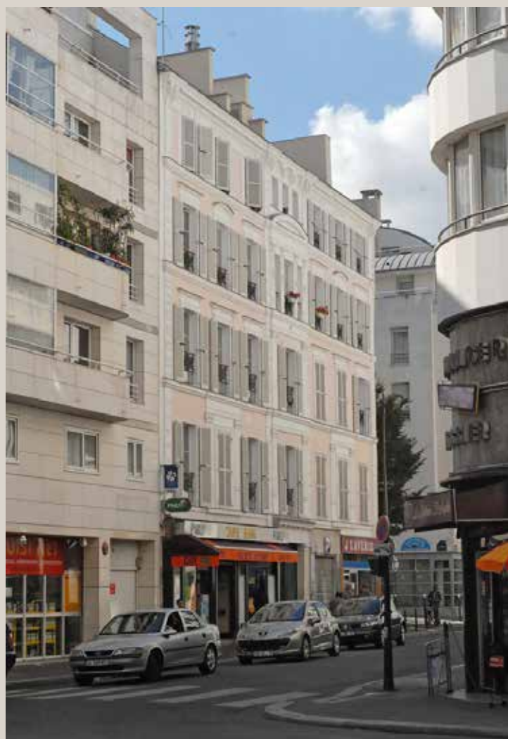
Vue de la façade sur rue après sa rénovation, en 2010.
