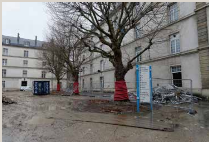
Vue actuelle de la place d'armes en travaux.
