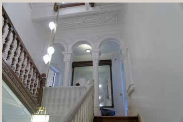
Ci-contre et ci-dessus : vues actuelles du palier du premier étage.
