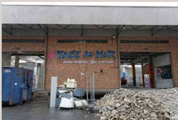
Vue des travaux de démolition engagés depuis 2015.
