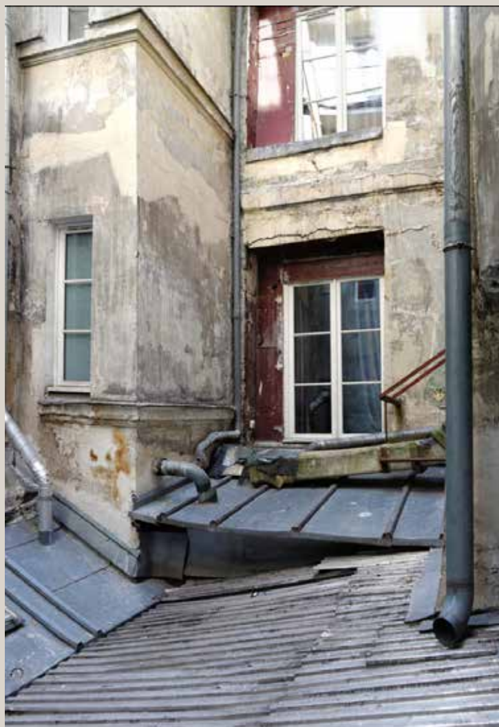
Vue actuelle de la façade du bâtiment du fond de la cour.
