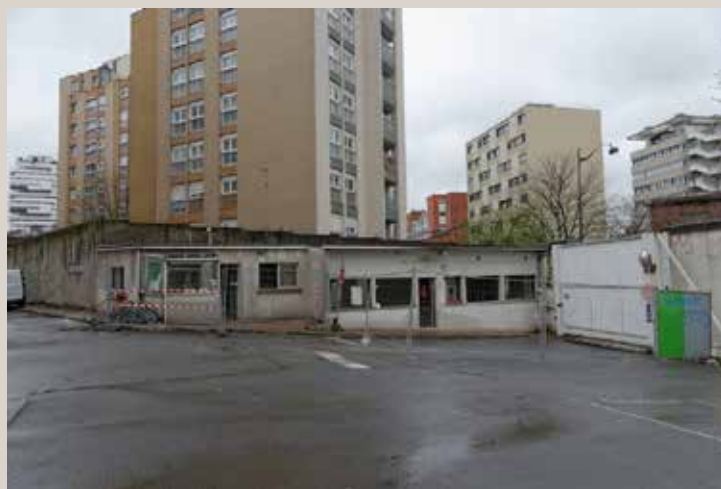
Vue actuelle des bâtiments annexes en cours de démolition.
