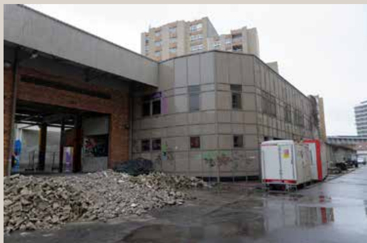
Vue actuelle de l'ancien bâtiment de tri postal des armées en cours de démolition.
