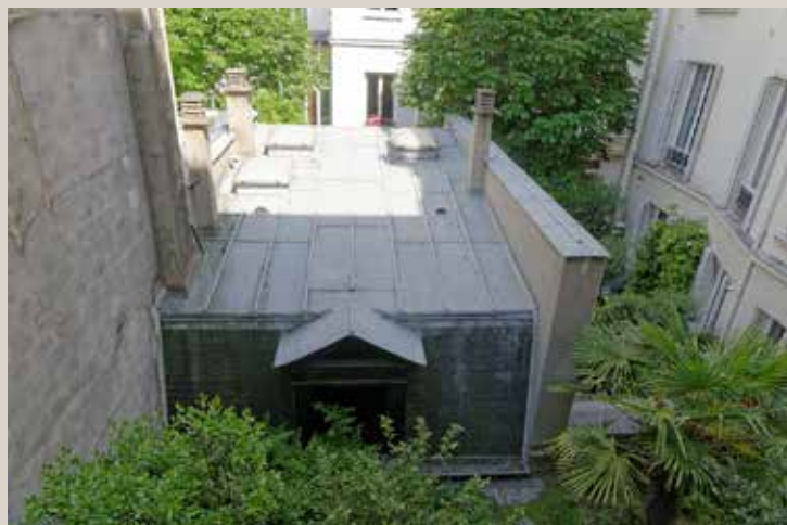
Vue actuelle de l'ancienne écurie, en fond de cour.
