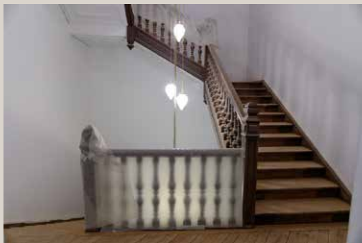
Vue actuelle de l'escalier.
