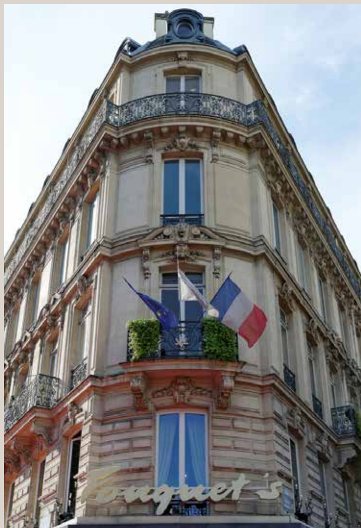
Vue actuelle de l'angle des deux avenues.
