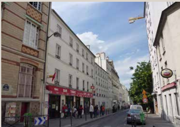
Vue actuelle des trois immeubles concernés.
