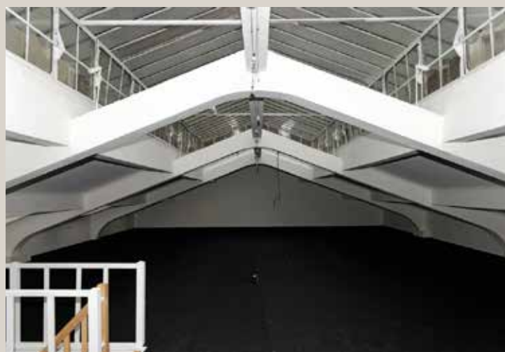
Vue actuelle de la nef sous verrière, qui serait démolie.
