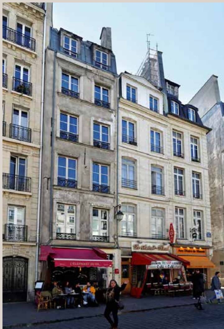
Vue actuelle de la façade sur rue.
