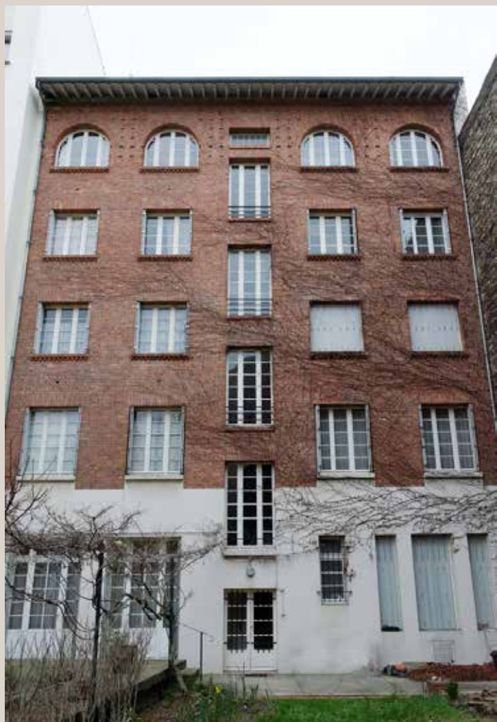
Vue actuelle de la façade, côté cour.
