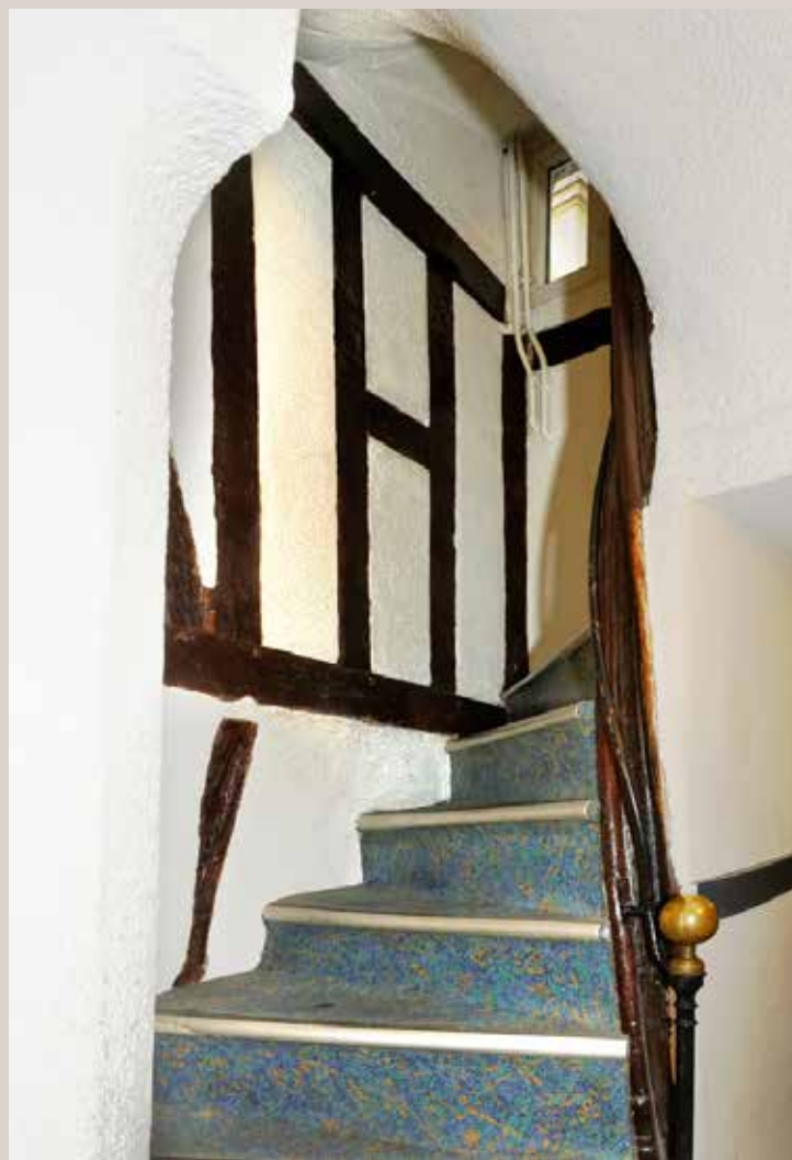
Vue actuelle de l'escalier en vis, du bâtiment sur rue, qui serait démoli.
