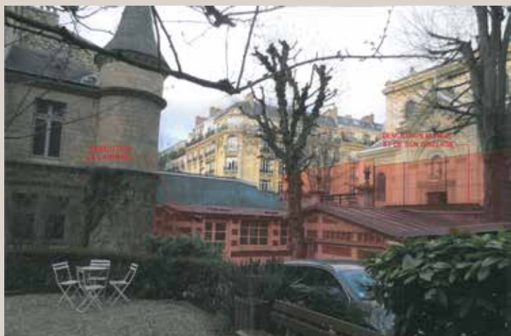
Vue des bâtiments à démolir depuis le jardin, vers la rue (© A-C. Perrot & F. Richard architectes).
