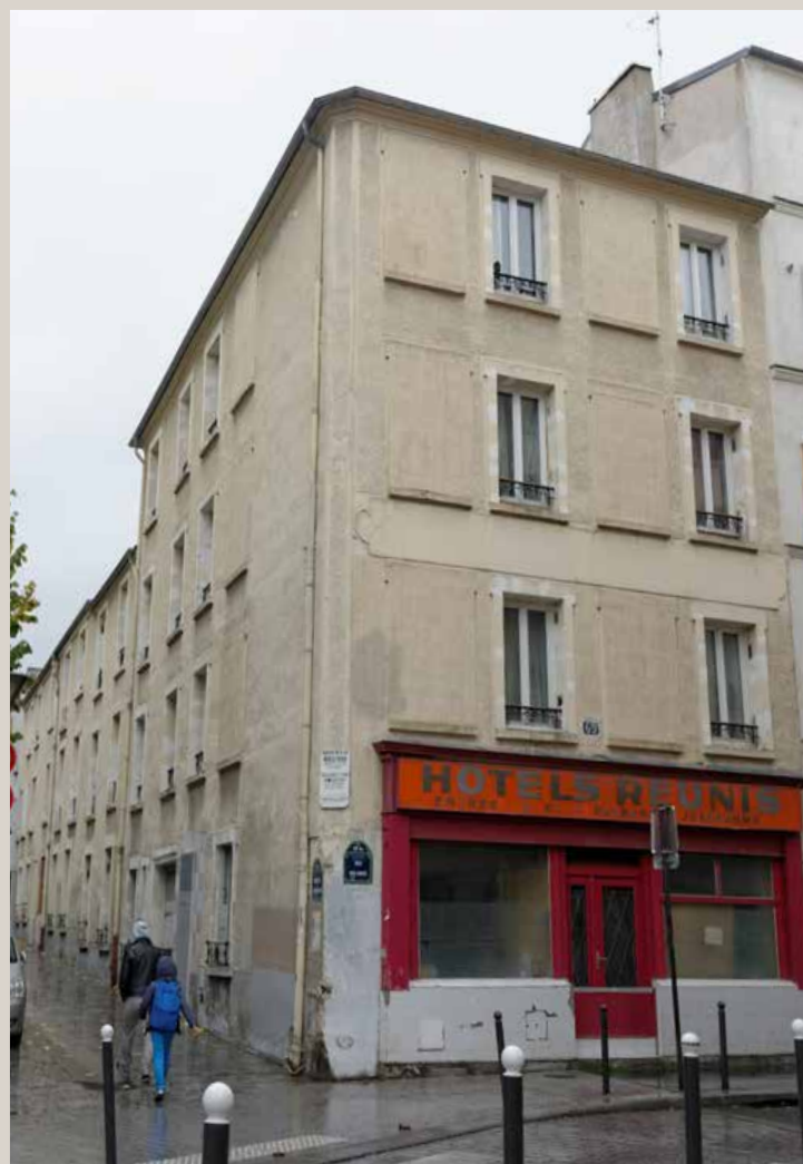
Vue du bâtiment d'angle, état existant.
