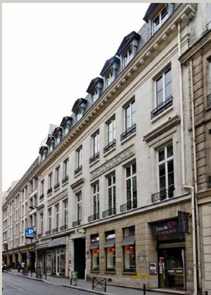
Vue actuelle de la façade, rue du Faubourg-Poissonnière.
