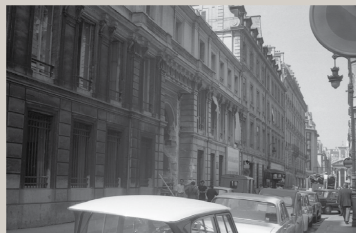
Vue des bâtiments de la banque Rothschild en cours de démolition (1967).
