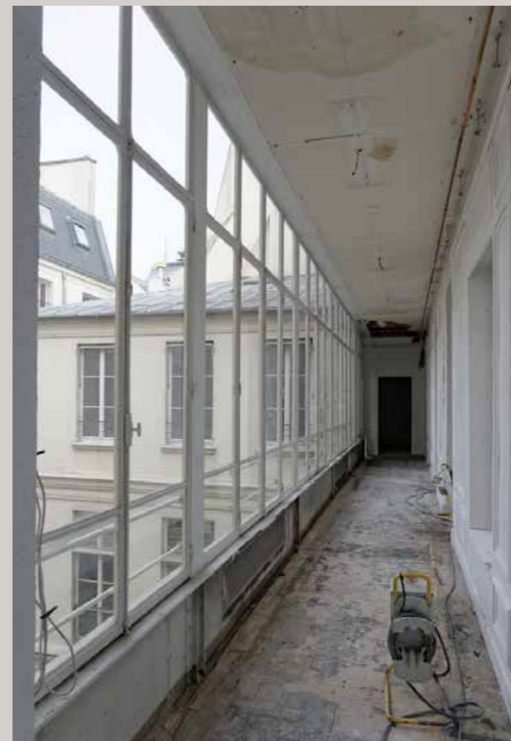
Vue actuelle de la galerie métallique au 2 e étage.
