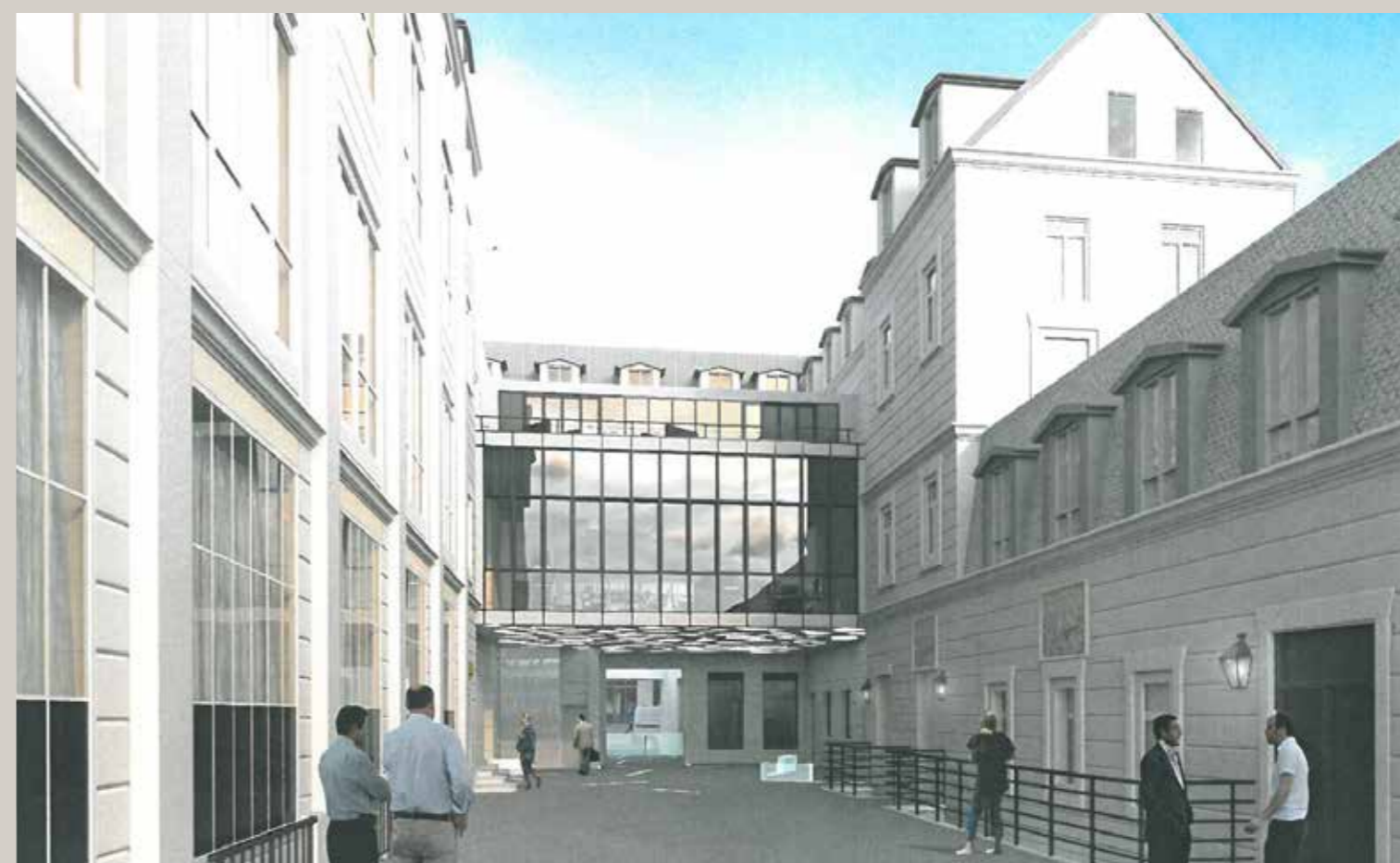
Vue perspective de l'état projeté. L'extension ajoutée devant les coursives du XIX e siècle occuperait tout l'espace de la cour au-dessus du rez-de-chaussée (© AETOS architectes).
