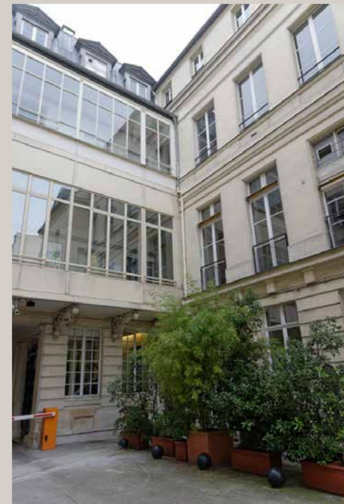
Vue actuelle du revers du logis principal et de la façade de l'aile gauche.
