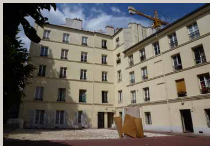
Vue des façades côté cour.
