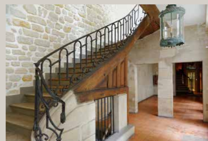
Vue actuelle du départ de l'escalier.
