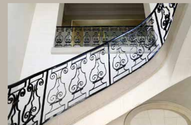
Vue actuelle du grand escalier entre le rez-de-chaussée et l'étage.
