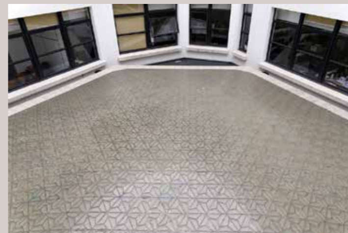
Vue actuelle de l'extrados de la voûte en béton translucide.
