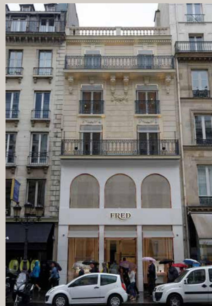
Vue actuelle de la façade.
