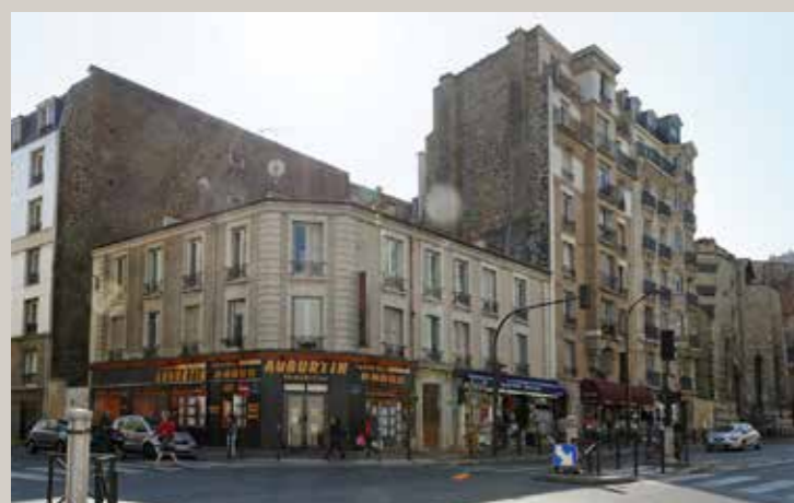
Vue actuelle de l'immeuble. A droite, la rue de la Chapelle.
