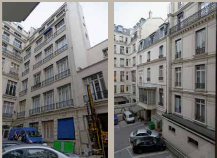
Vues actuelles de la cour intérieure.
