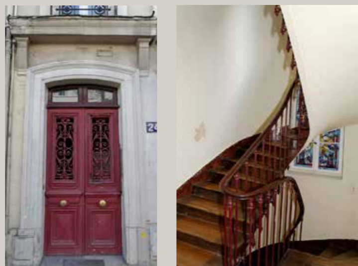
Ci-dessus à gauche, porte d'entrée actuelle. A droite, l'escalier actuel.
