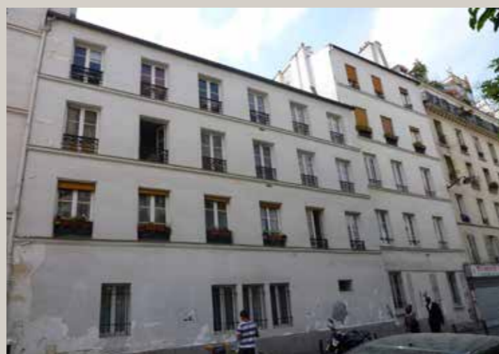
Vue des façades sur la rue des Poissonniers.
