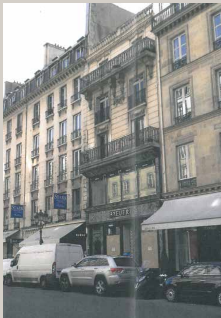
Vue de l'immeuble avant la dépose de la devanture Vever.
