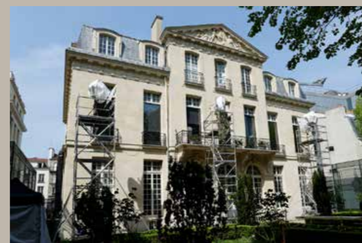
Vue actuelle de la façade côté jardin.
