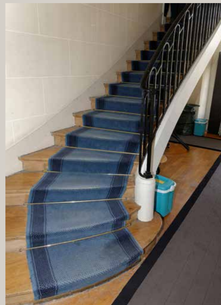
L'escalier secondaire, remplacé au XX e siècle (à gauche). Vue depuis le palier du premier étage (à droite).
