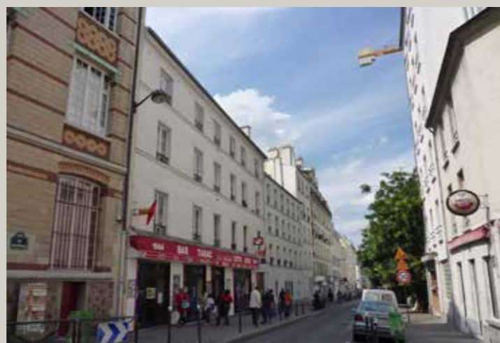
Vue des façades sur la rue des Poissonniers.
