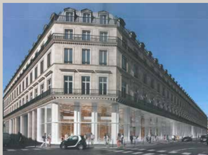
Perspective de l'état projeté à l'angle des rues Marengo et Saint-Honoré (© Braun + associés architectes).
