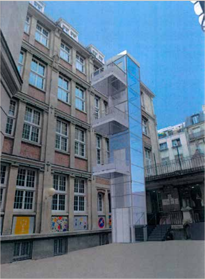
Vue projetée de la cour et du nouvel ascenseur (© ed architectes).
