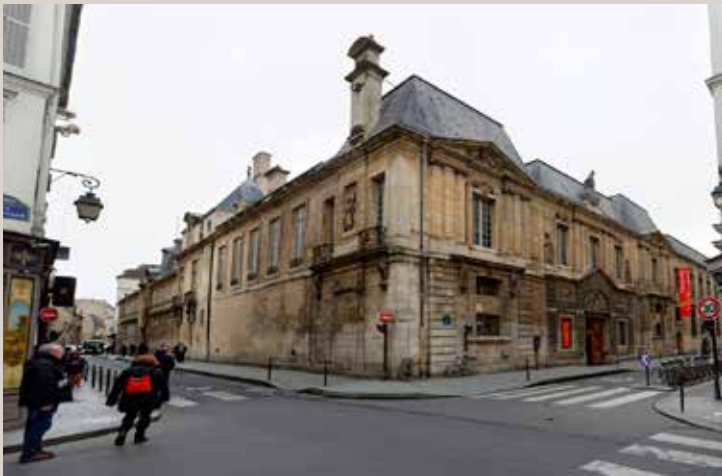
Vue des bâtiments depuis l'angle des rues de Sévigné et des Francs-Bourgeois.
