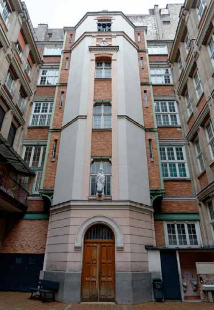
Vue actuelle de la cage d'escalier en avant-corps central, au fond de la cour.
