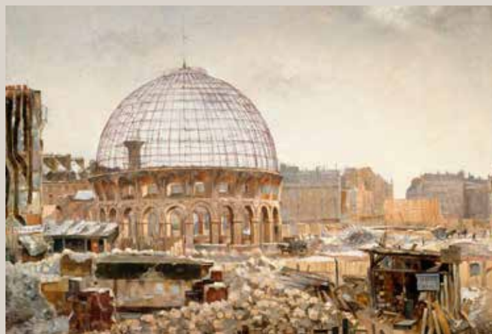
Ferdinand Bellan, La Démolition de la Halle au blé , huile sur toile, 1888 (© Musée Carnavalet / Roger-Viollet).
