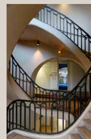
Vue actuelle de l'escalier à double révolution.
