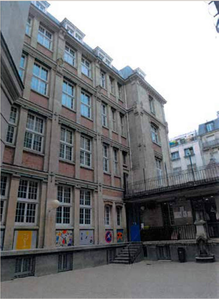
Vue actuelle de la cour (© ed architectes).
