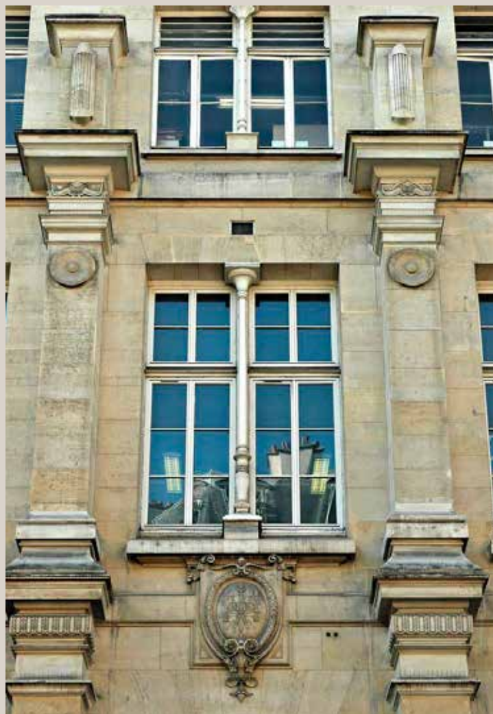
Détail de la façade rue du Louvre.
