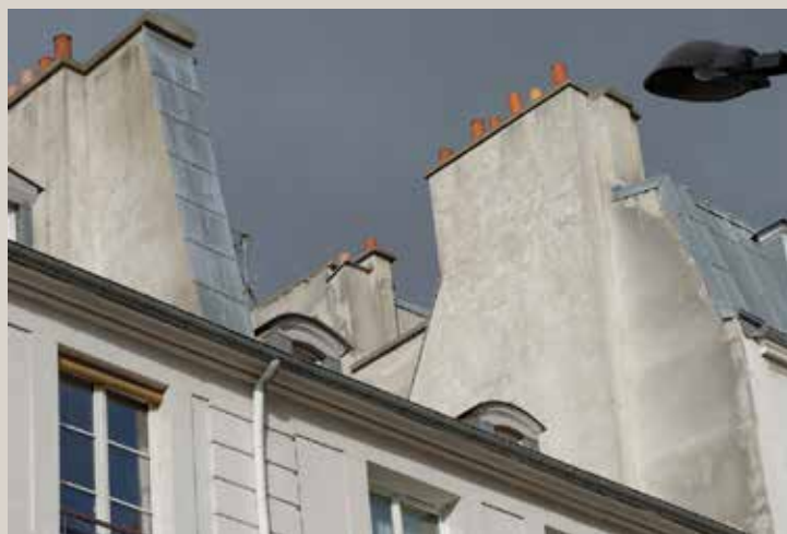
Détail des souches de cheminées visibles depuis la rue.
