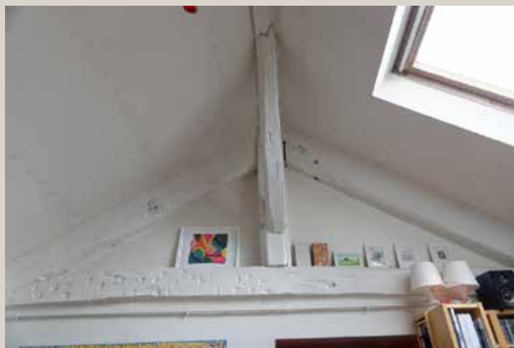
Détail des poutres qui soutiennent la toiture dans l'appartement du dernier étage.
