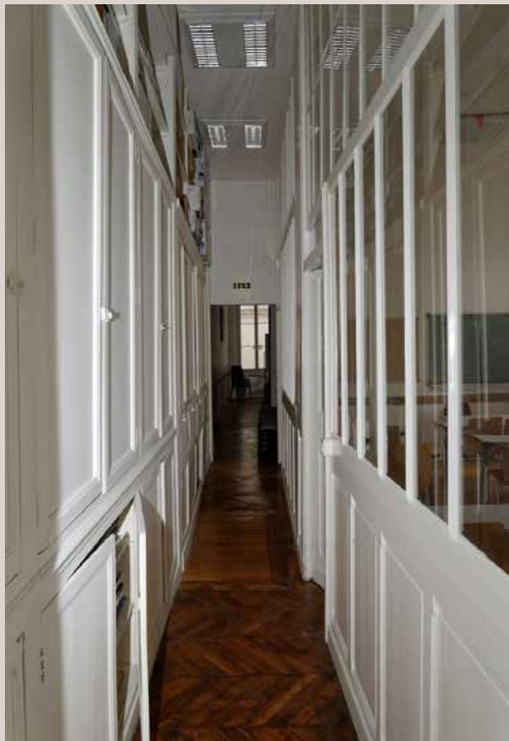
Vue du premier étage où serait créée la trémie des nouvelles circulations verticales.
