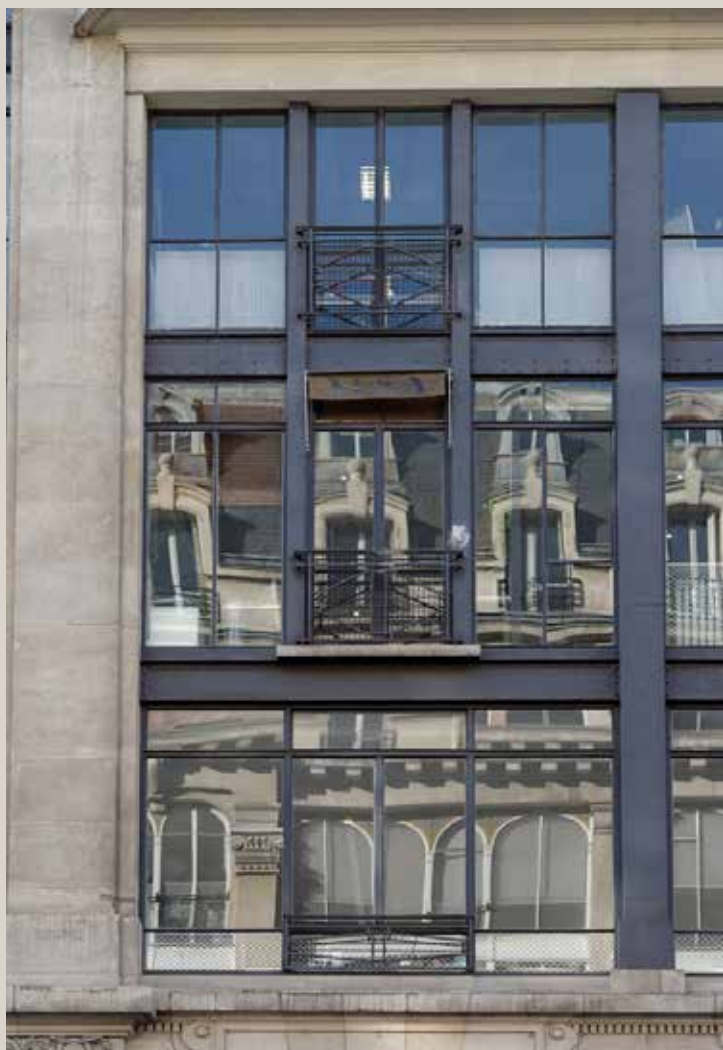
Détail montrant l'organisation de la structure des menuiseries.
