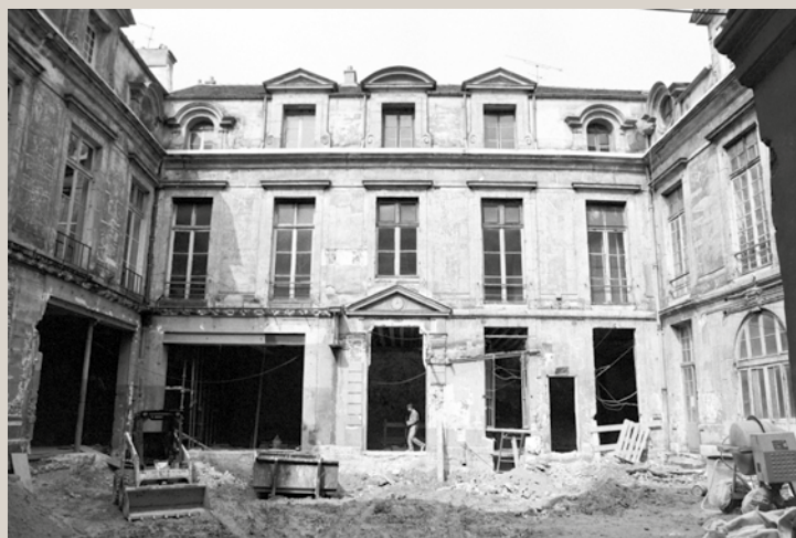
Vue de la cour pendant les travaux de restauration (Casier archéologique).
