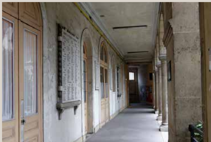
Vue actuelle de la galerie du rez-de-chaussée du bâtiment de l'administration.
