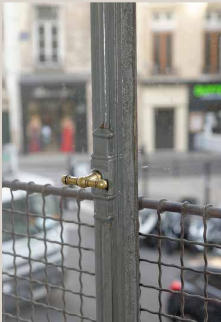
Détail d'un ouvrant.
