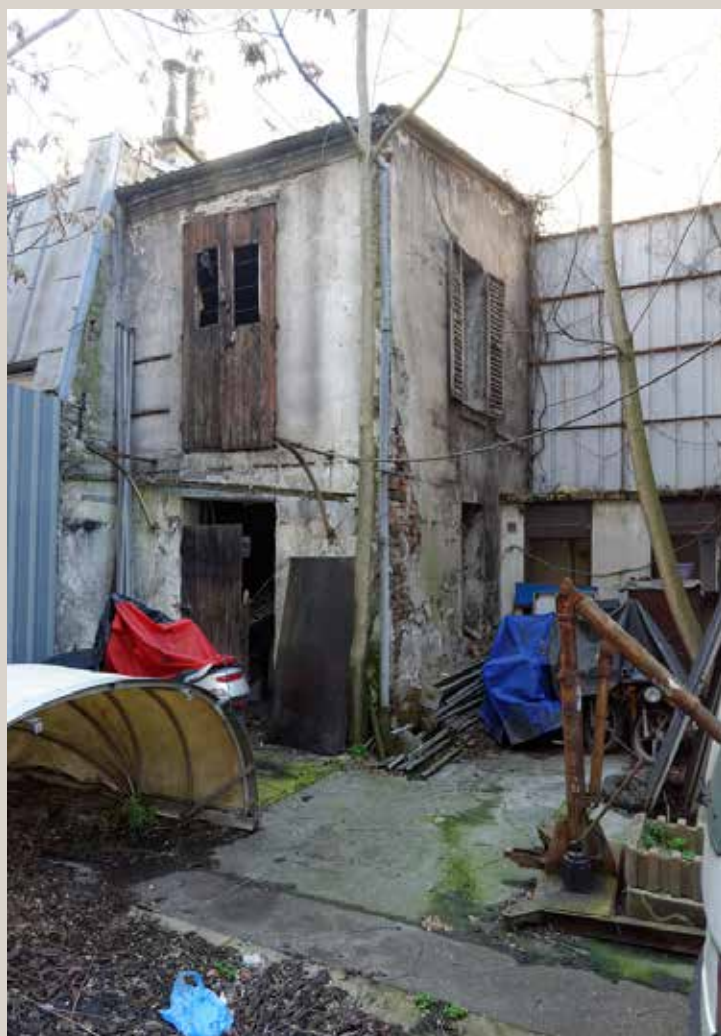
Vue actuelle de l'appentis au fond de la cour.
