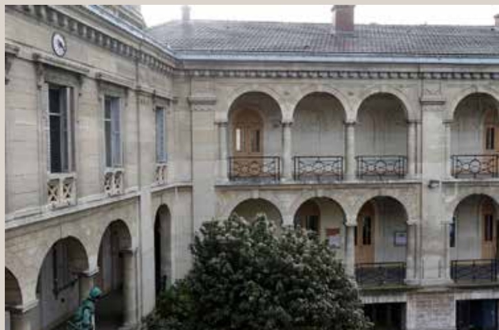
Vue de l'emplacement de la future passerelle.
