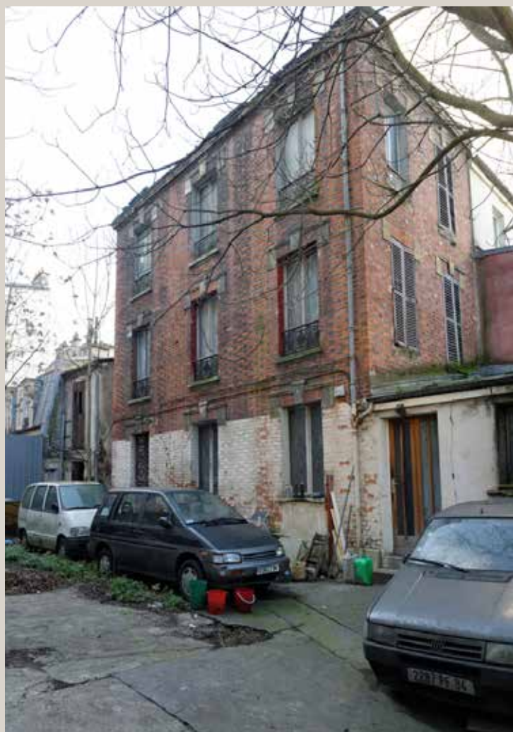
Vue actuelle du pavillon principal.
