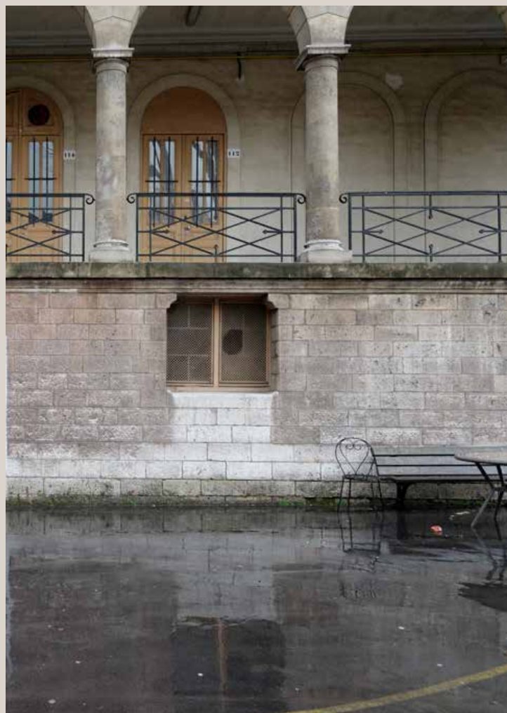
Vue du soubassement où sont prévus de nouveaux percements.
