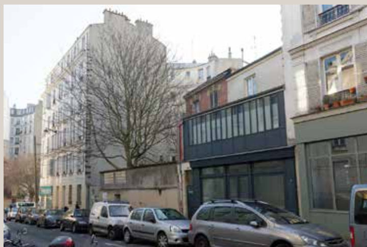
Ci-dessus, vues actuelles du bâtiment depuis la rue des Envierges.
