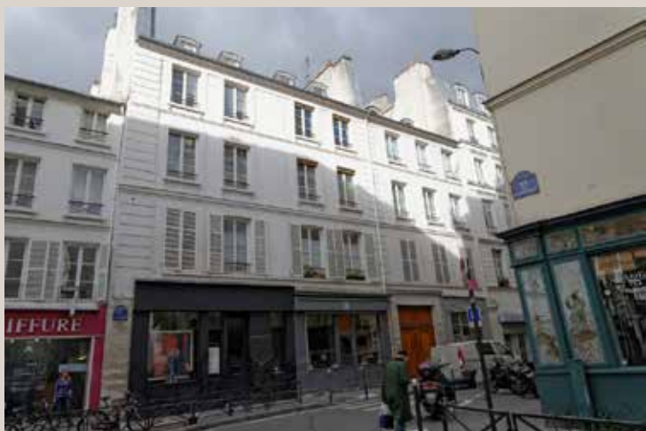
Vue actuelle de la façade sur rue.
