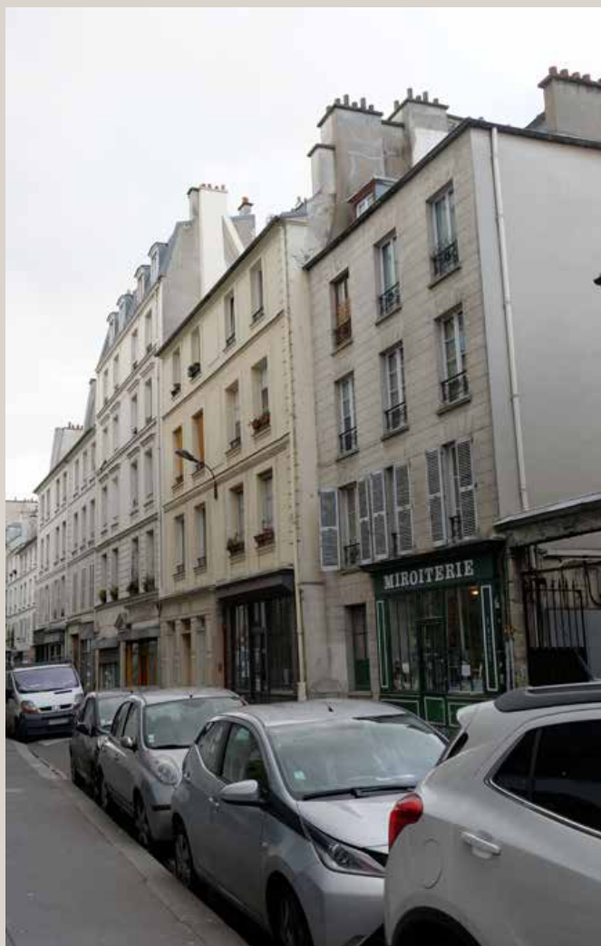
Vue actuelle de la séquence d'immeubles issue du lotissement de 1807 : les n° 11, 13, 15 et 17 de la rue Saint-Bernard.
