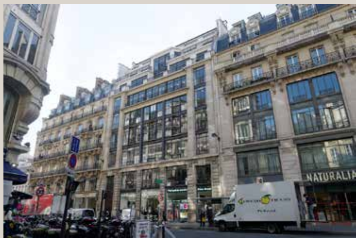
Vue de la rue Réaumur.
