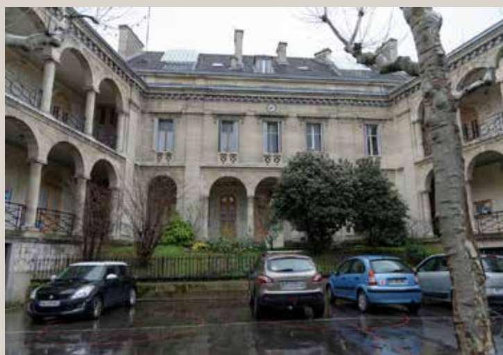
Vue, depuis la cour, du bâtiment de l'administration devant lequel est prévue une passerelle au premier étage.
